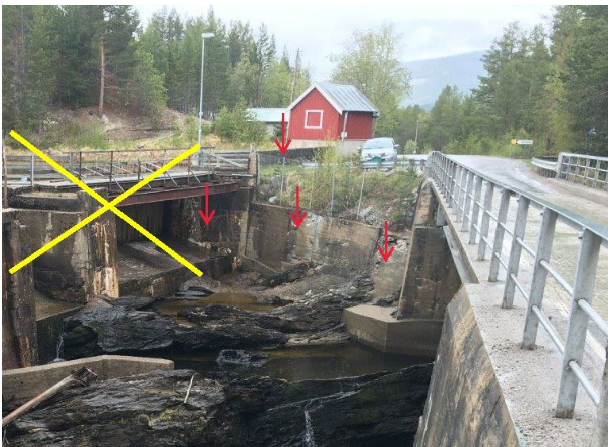
Figur 13 Bildet viser del som skal bestå angitt med røde piler og del som skal rives angitt med gult kryss, sett fra veibru i østlig retning
