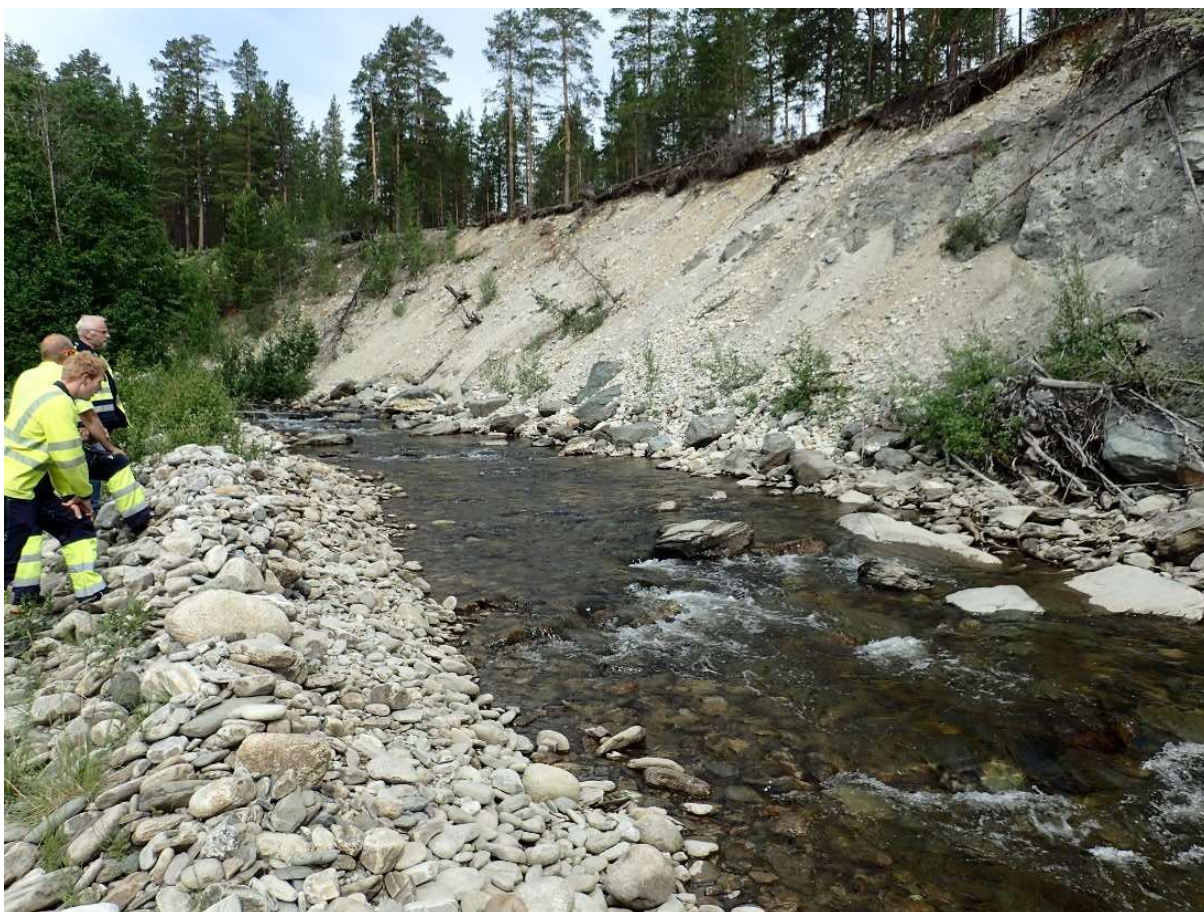
Figur 4 Bratt skråning i yttersving med aktiv erosjon. Sandsvalereir ses i det mørkere feltet øverst til høyre i bildet.
