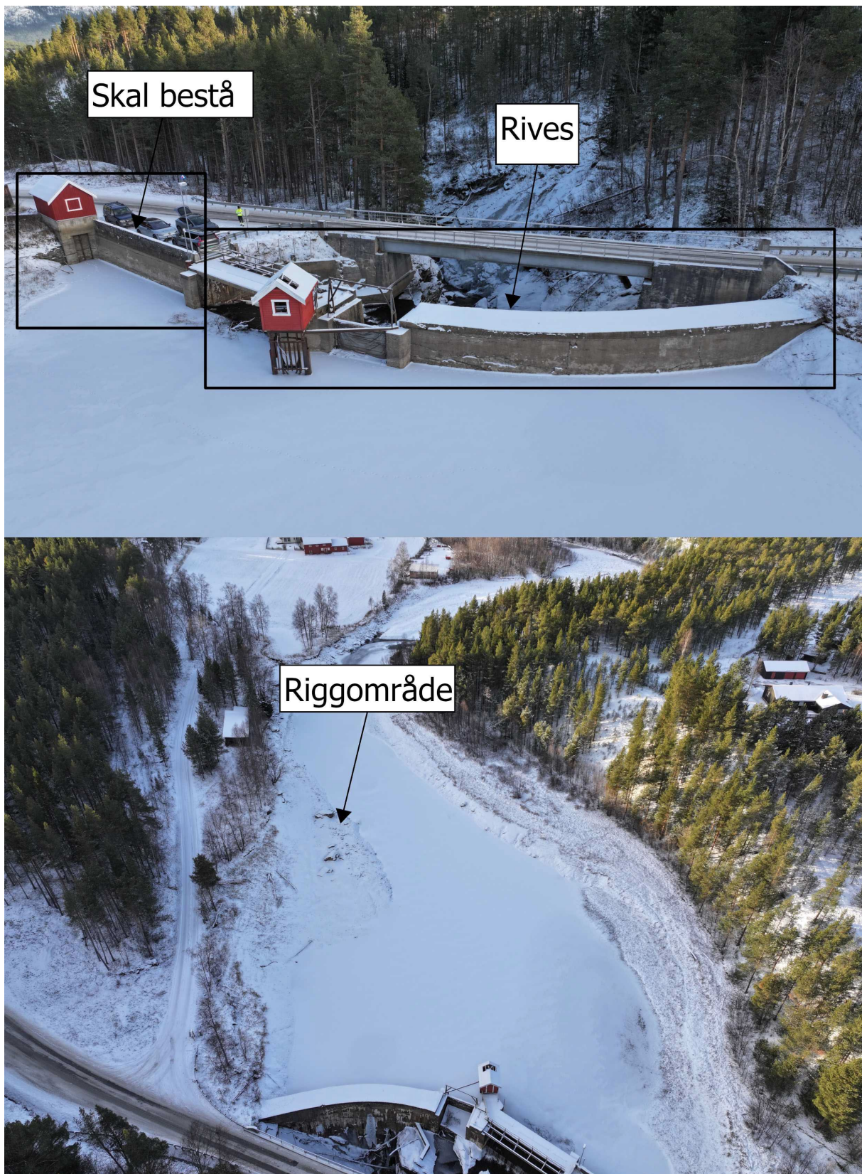
Figur 11 Dronefoto av dam sett fra oppstrøms side og tiltaksområdet sett fra nedstrøms side. Del av dam som skal bestå og rives og plassering av riggplass er omtrentlig angitt i bildene.
