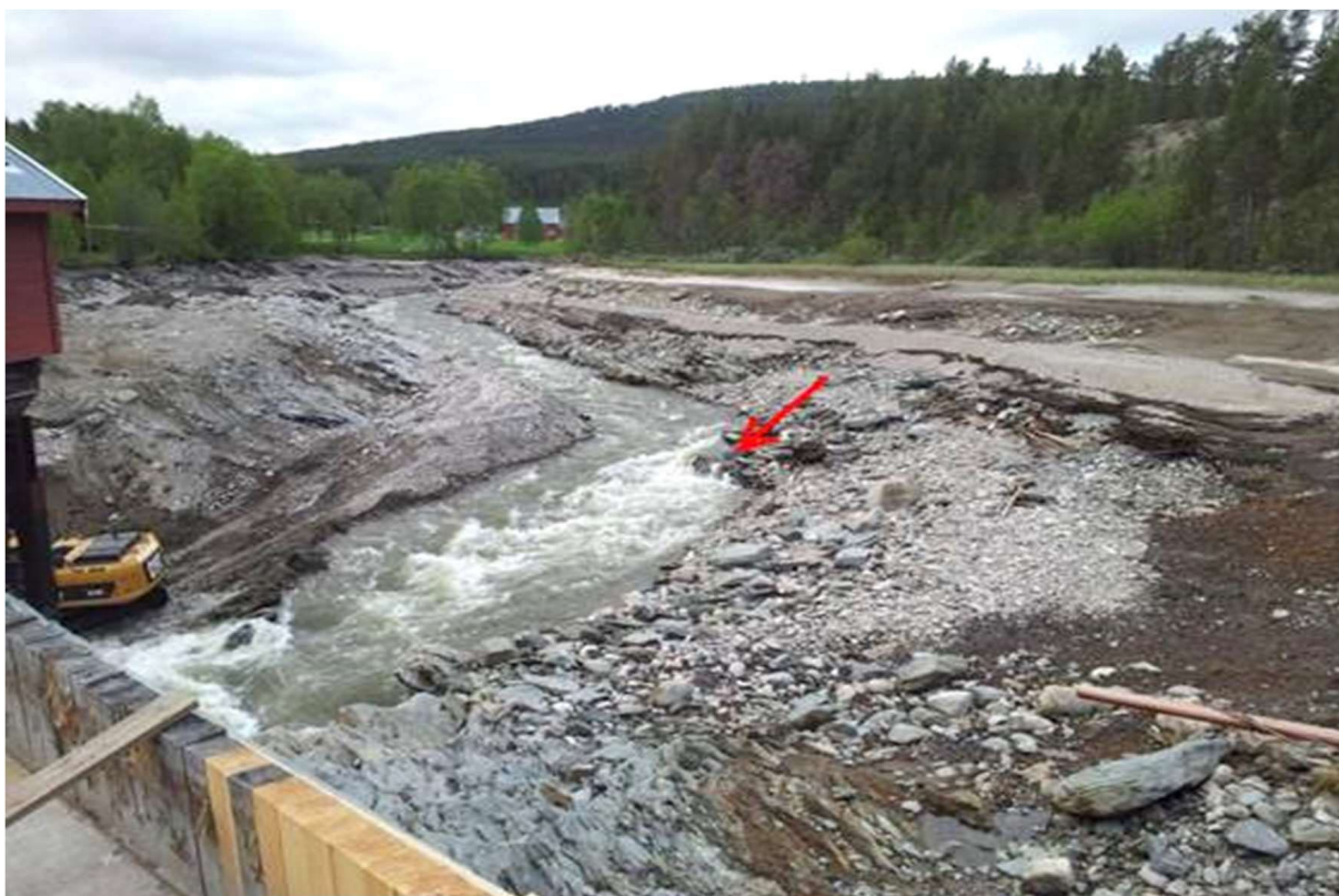
Figur 12 Bildet viser inntaksmagasinet etter nedtapping i forbindelse med vedlikehold i 2013. Rød pil viser innmålt punkt 7,99 m under dammens sidevange ved inntakshuset.
