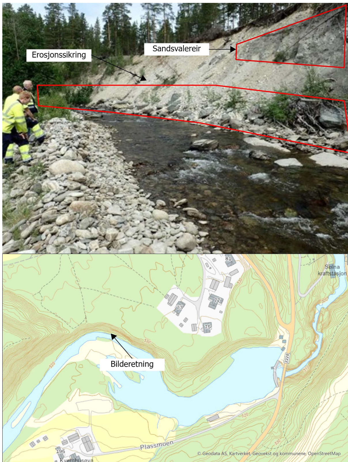
Figur 10 Bildet viser sandsvalereir og omtrentlig høyde på erosjonssikring i erosjonsutsatt skråning.
