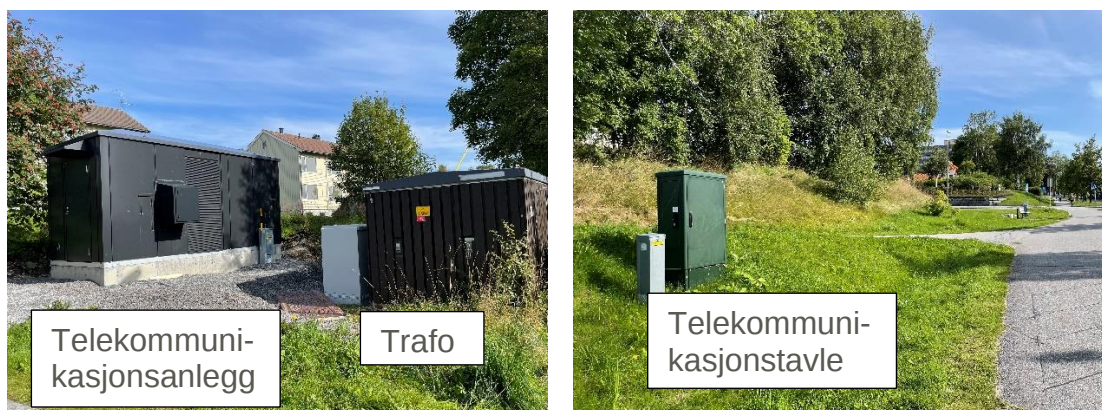
Figur 4.13-2 Foto med eksisterende tekniske anlegg i planområdet
