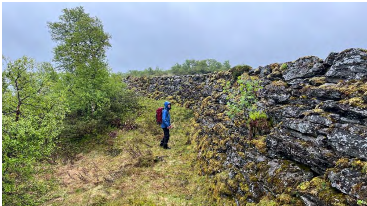
Figur 16 Nedstrøms side av sekundærdammen. Her skal det graves av masser i en bredde på ca. 1 m i damfoten for lekkasjeovervåking. Det skal også etableres en sti og derfor ryddes noe vegetasjon.
