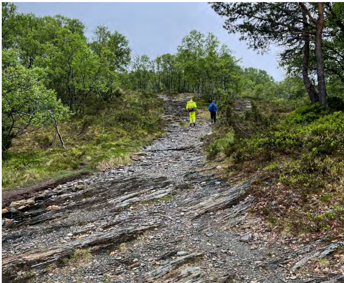
Figur 19 Stedvis er veien opp til hoveddammen god nok som den er i dag, mens det andre steder må gjøres noen tiltak i terrenget. Maskinene som kjører på strekningen skal ha gummibelter.
