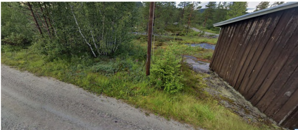
Figur 3-7. Område for rigg i forbindelse med driftshytte. Bilde hentet fra Google Street View.
