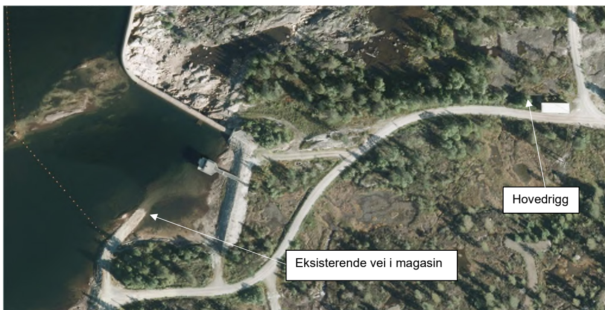
Figur 3-6. Flyfoto av anleggsområdet. Eksisterende vei i magasinet er synlig på lav vannstand (flyfoto fra Finn.no).
