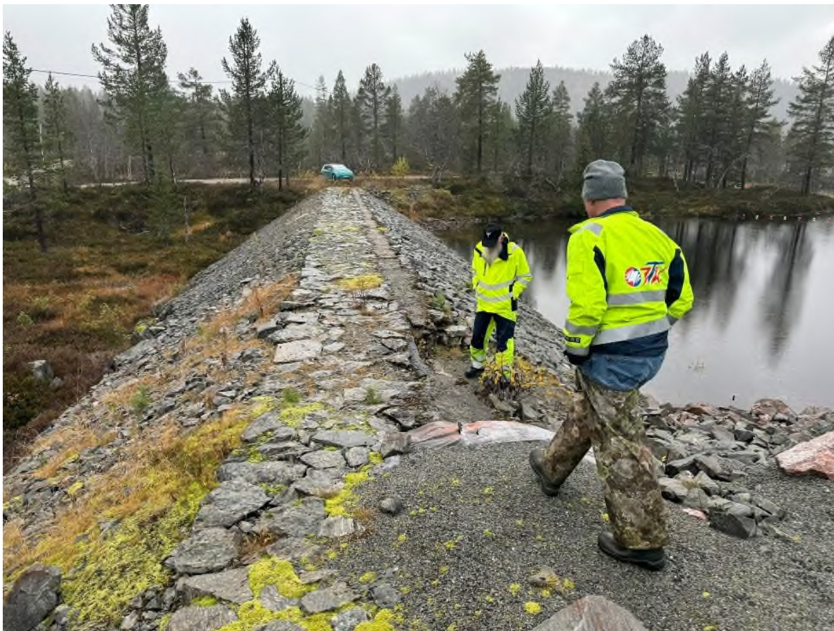
Figur 3-3. Fyllingsdammen med adkomstveien over, fremst i bildet.
