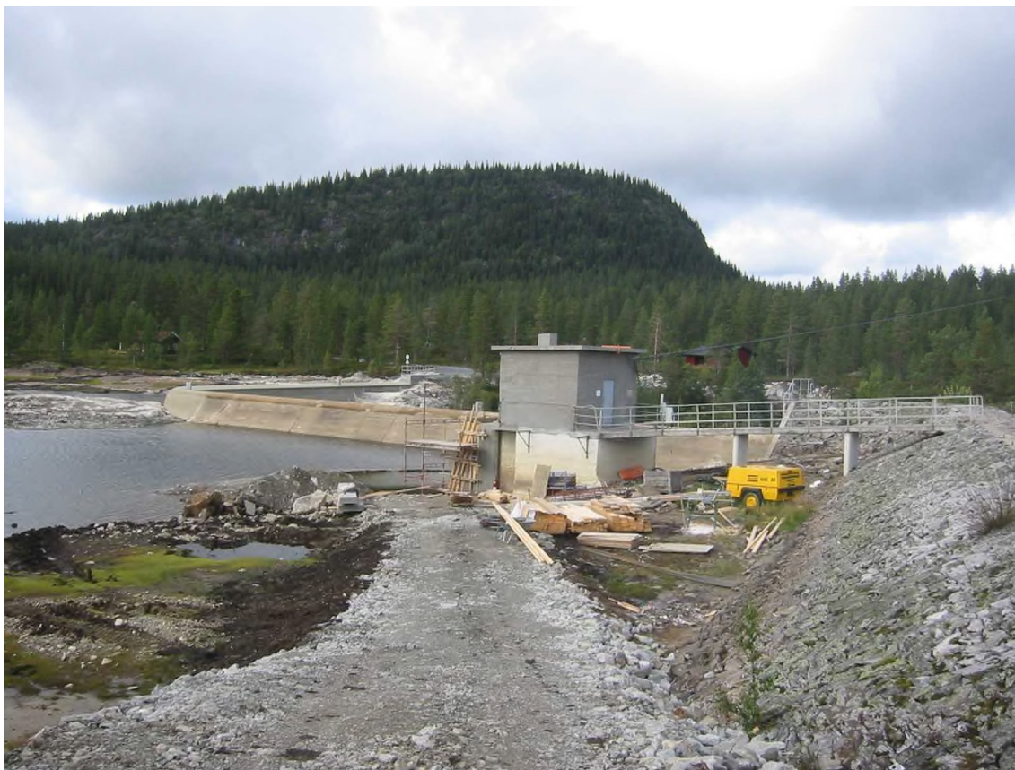
Figur 3-9. Magasinvannstand på omtrentlig kt. 654, ifm. utførelse av tiltak på dammen i år 2005. Bildet er tatt av dameier.
