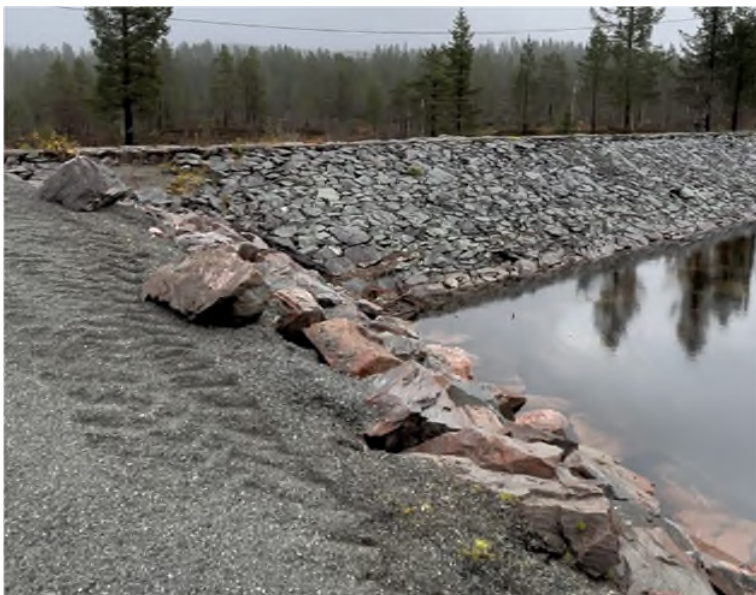
Figur 2-3. Adkomstvei til inntaket går i dag over dammen, i form av en veifylling med plastrede kanter.
