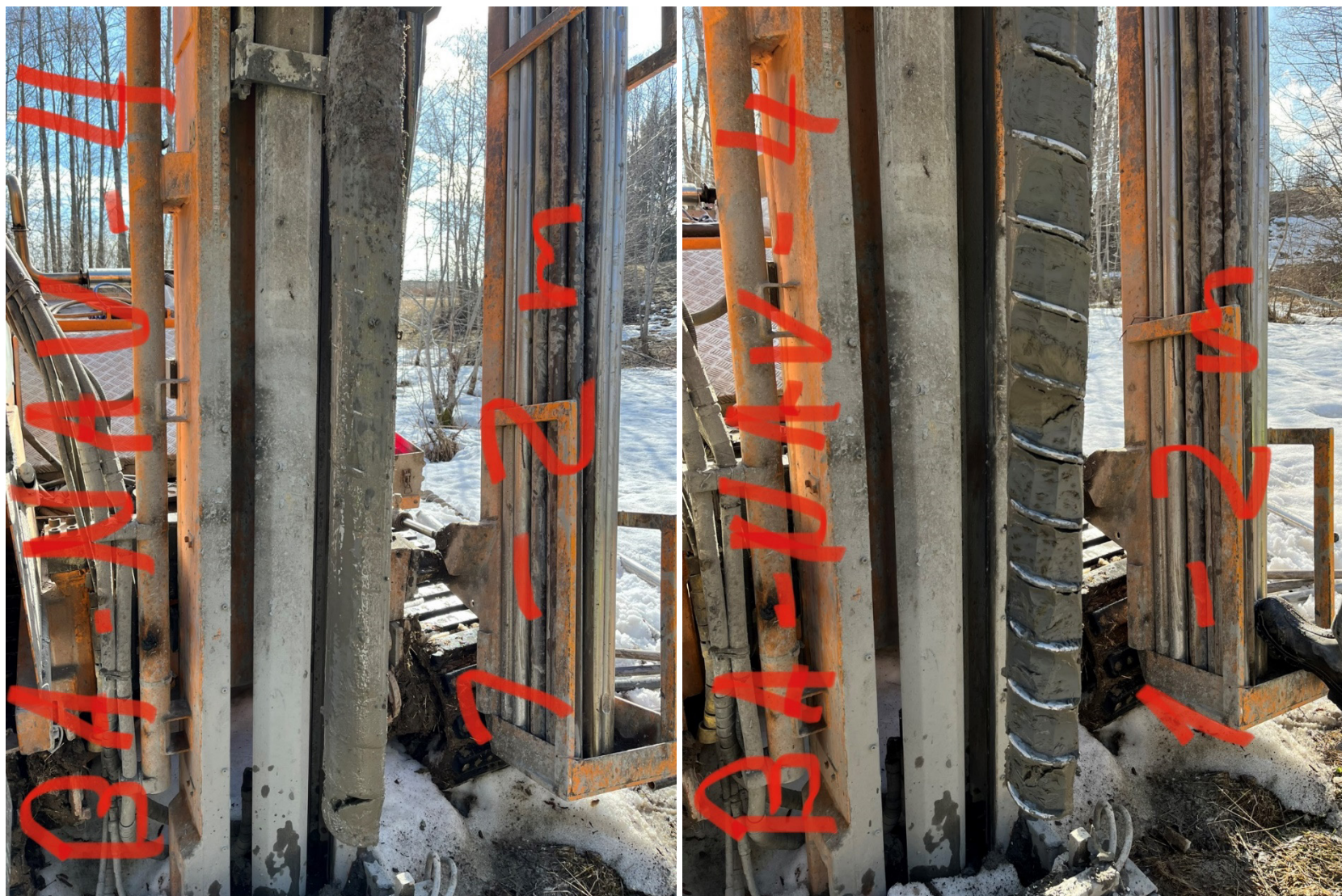
Figur 3-3 Naverboring ved BA-NAV5 (merk navneendring), 1-2 meter. Venstre: optrukket prøvemateriale. Høyre: avskrapet materiale.
