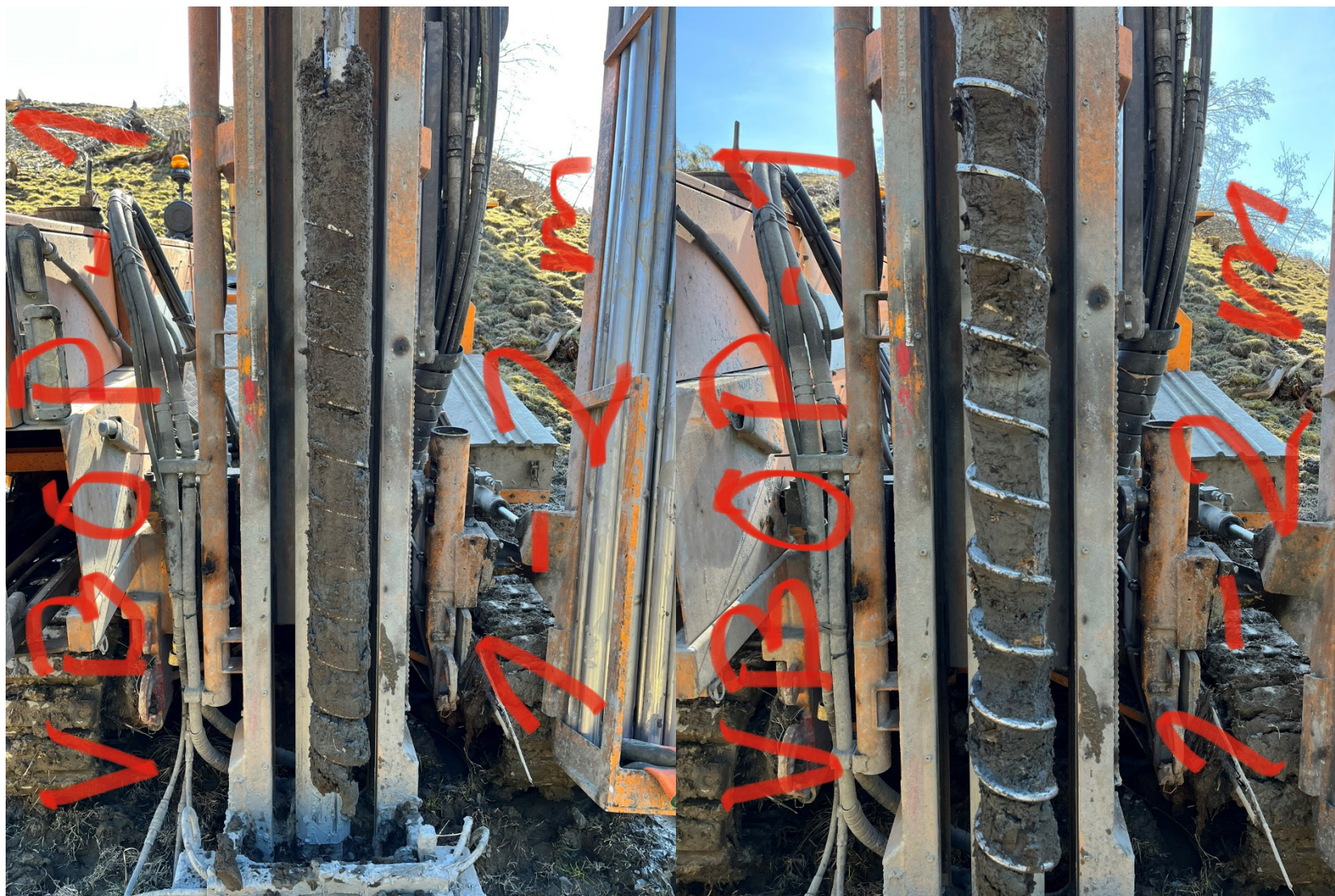
Figur 3-18 Naverboring ved VBOP-1, 1-2 meter. Venstre: optrukket prøvemateriale. Høyre: avskrapet materiale.
