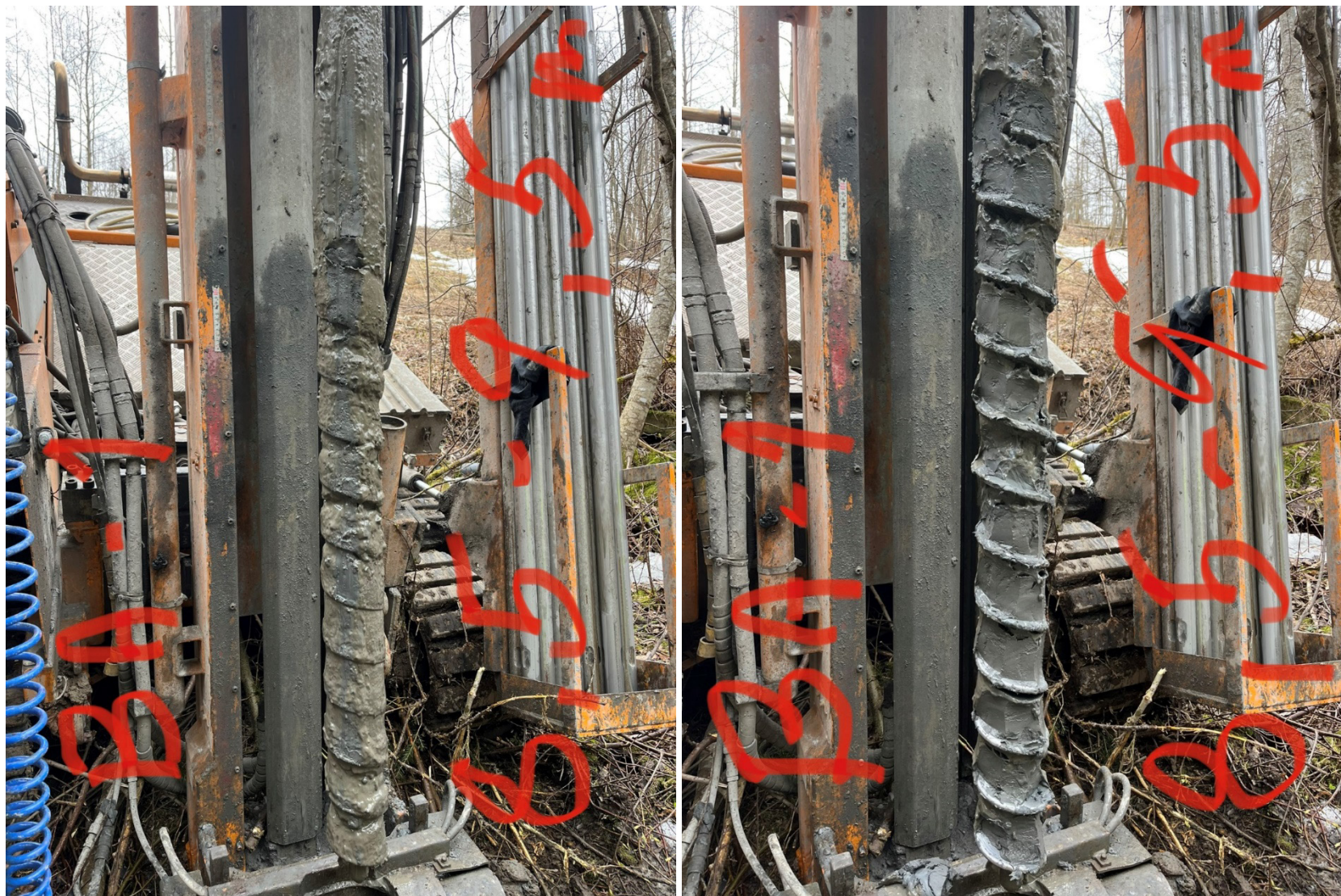
Figur 3-2 Naverboring ved BA-1, 8.5-9.5 meter. Venstre: opptrukket prøvemateriale. Høyre: avskrapet materiale.
