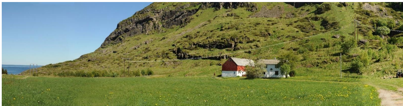
Figur 5-6 Fotovisualisering av alternativ 4.0 fra Beskeland. Visualiseringen viser kraftledningens nærføring til boligen og kabelendemasten til venstre i bildet. Se vedlegg 2 for ytterligere detaljer.
