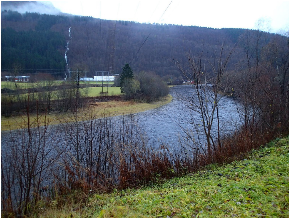
Figur 4-9: Ovenfor Trollheimen kraftverk (1. nov.), Elv med stryk og kulper (Cv)
