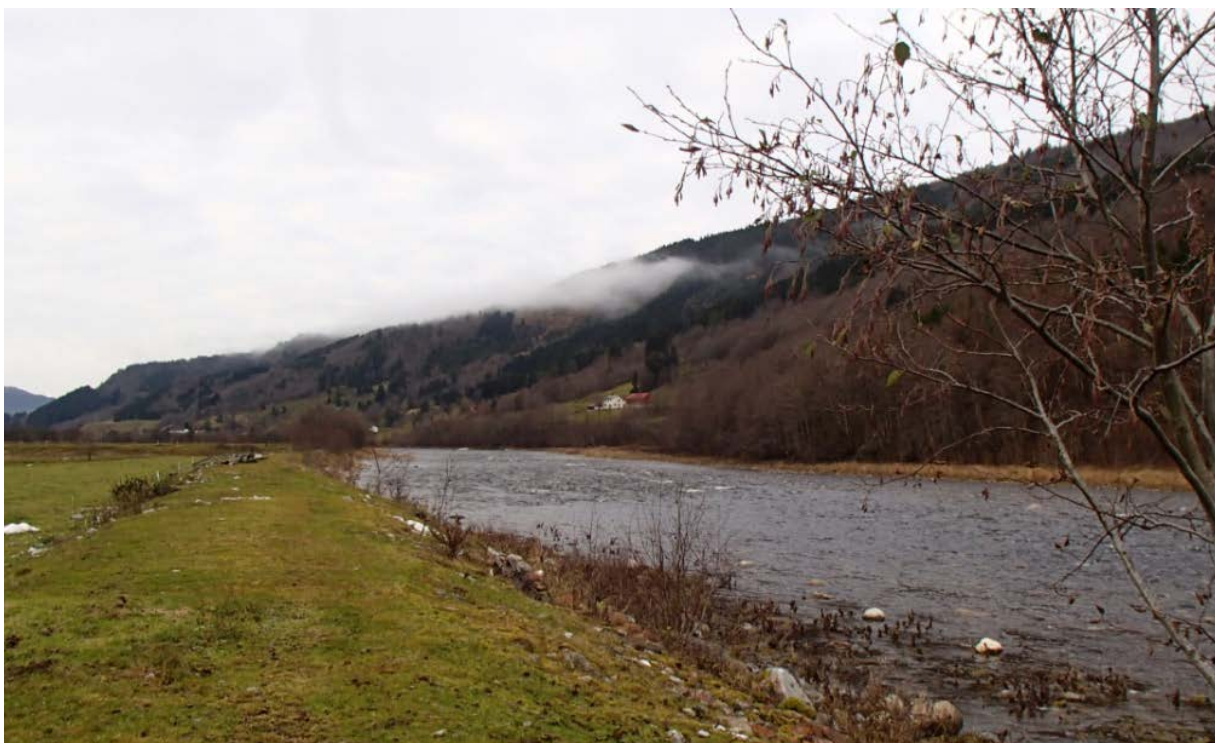
Flomsikring ved Sande. Løsmassene brukt til flomsikringen ble gravd ut av elveleiet, som følgelig er blitt noe kanalisert.
