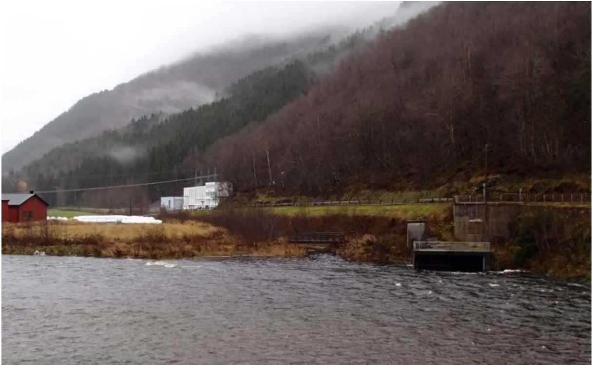
Trollheim kraftstasjon markerte grensen mellom øvre og nedre avsnitt.
