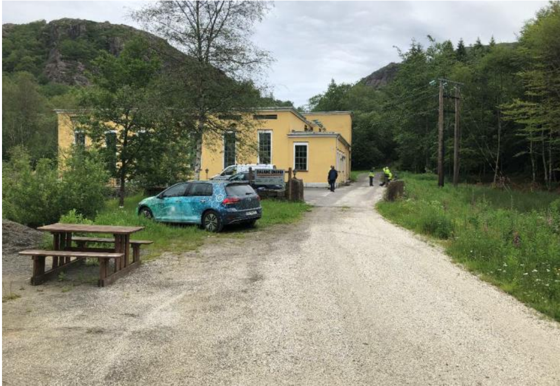
Adkomstveien til Grødemfoss kraftstasjon. Nytt stasjonsbygg er tenkt plassert til høyre for veien.
