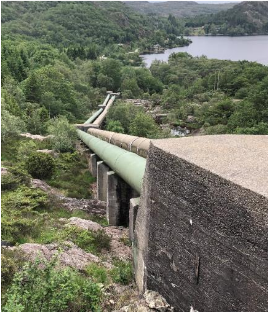
Eksisterende 2 rørgater til Grødemfoss kraftverk Rørgatene med fundamenter vil bli fjernet.
