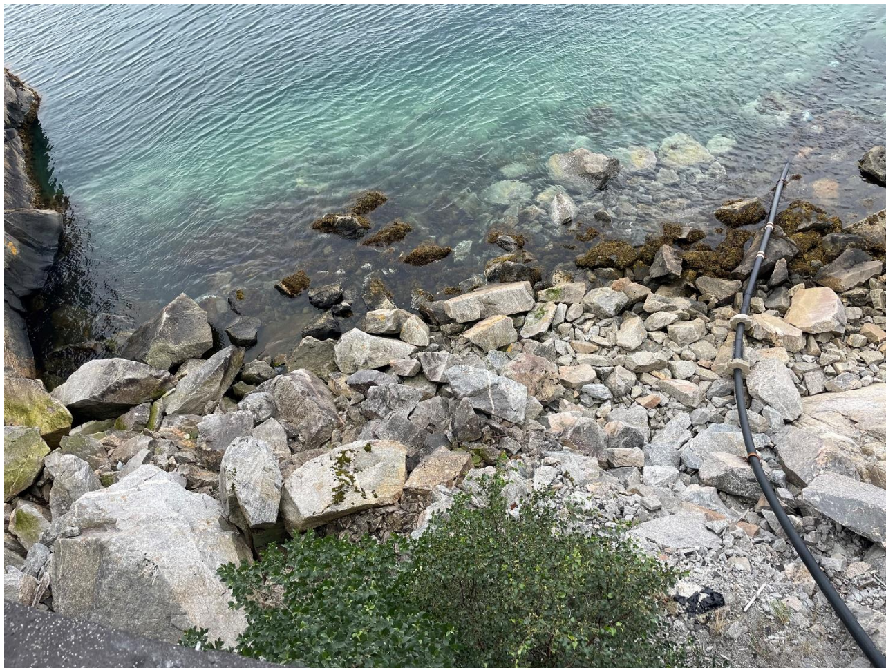
Figur 4-11 Bilde tatt fra fylkesvegen og ned mot utløpet av Hundåga. Vegfyllinga skjuler utløpet og oppvandring av anadrom fisk ansees som urealistisk. Foto: Sweco
