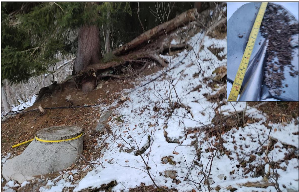
Figur 15. Grove permeable masser ved grunnvannsutak.
