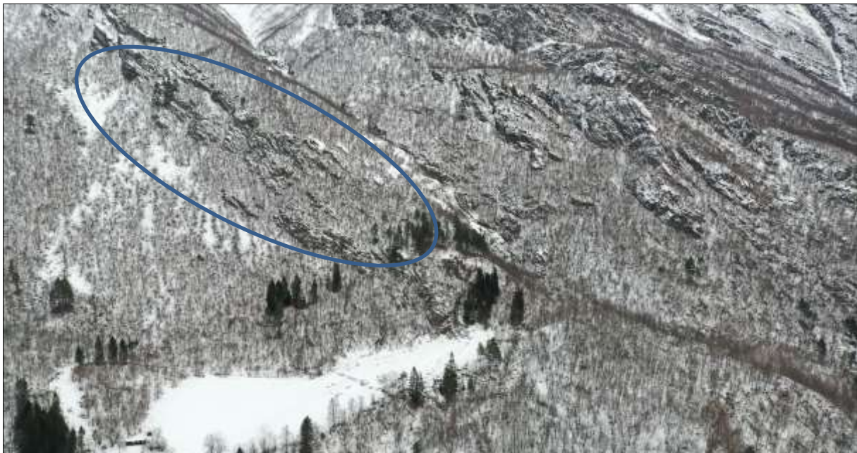
Figur 22: Potensielle losneområde for steinsprang som kan nå kartlagd område, utan å gå via elveløpet er lokalisert i fjellryggen på vestsida av elveløpet, ovafor tunnelpåhogget (blått omriss). Biletet er tatt mot nordaust.
