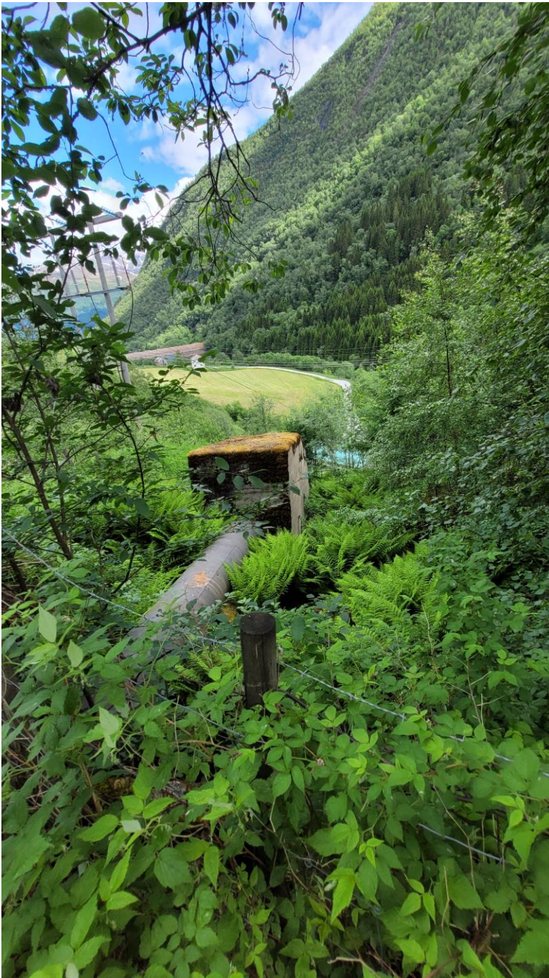
Bilde 3. Rørgate inne i kartleggingsområdet. Taket på kraftstasjonen (turkis) skimtes mellom buskene.
