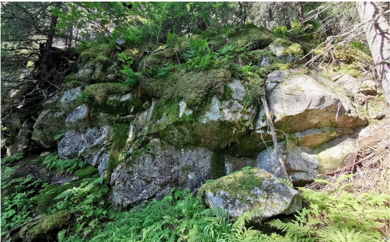
Bilde 6: Infopunkt 7 i Vedlegg 4. Bergskrent med avløste blokker i størrelsesorden ca. 0,5 \text{ m}^3 .
