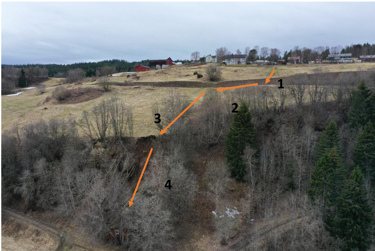
Figur 8: Oversikt over hvor det er tegn på overflateavrenning (1-3) og skredet (4).
