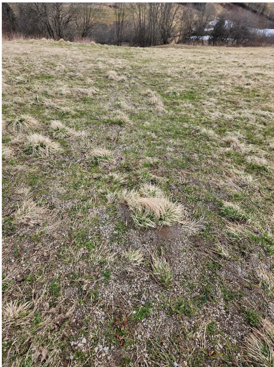
Figur 18: Tegn på overflateavrenning og grus på nedre gresslette. Bildet er tatt nedover (mot øst) og vannet har rent fra nederst til øverst i bildet. Skredet løsnet helt øverst i bildet der terrenghelningen øker.
