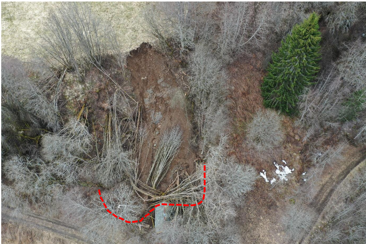
Figur 10: Dronefoto av skredet. Hytta er synlig nederst i bildet.
