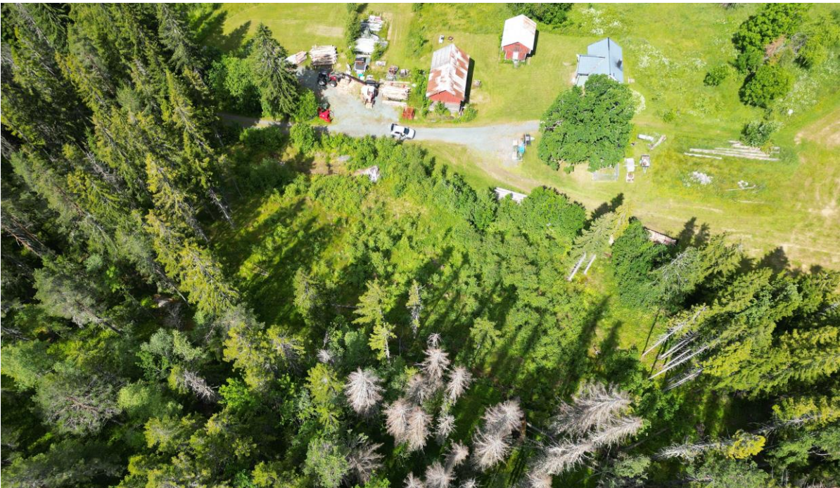
Bilde 5: Infopunkt 1 i Vedlegg 4. Dronebilde av løsmasseskråning og eksisterende bygninger i kartleggingsområdet. Sett mot nordvest.
