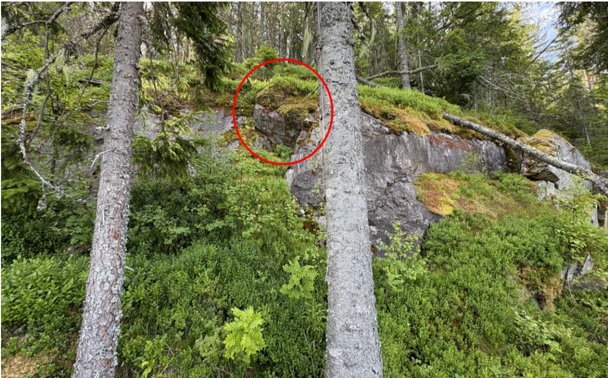
Bilde 8: Infopunkt 3 i Vedlegg 4. Tilsynelatende avløst blokk i bergskrent på grensen til kartleggingsområdet. Samme som i Bilde 7. Sett mot sørøst.
