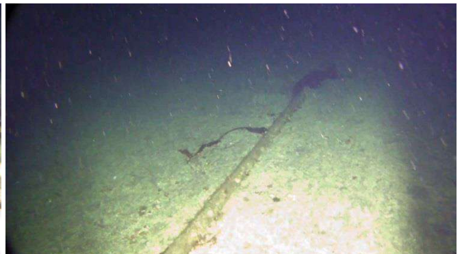
Eksisterende kabel på 100-25m dyp
