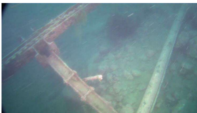
Ramme/renne og trekkerør i landtak (10-20m dyp)
