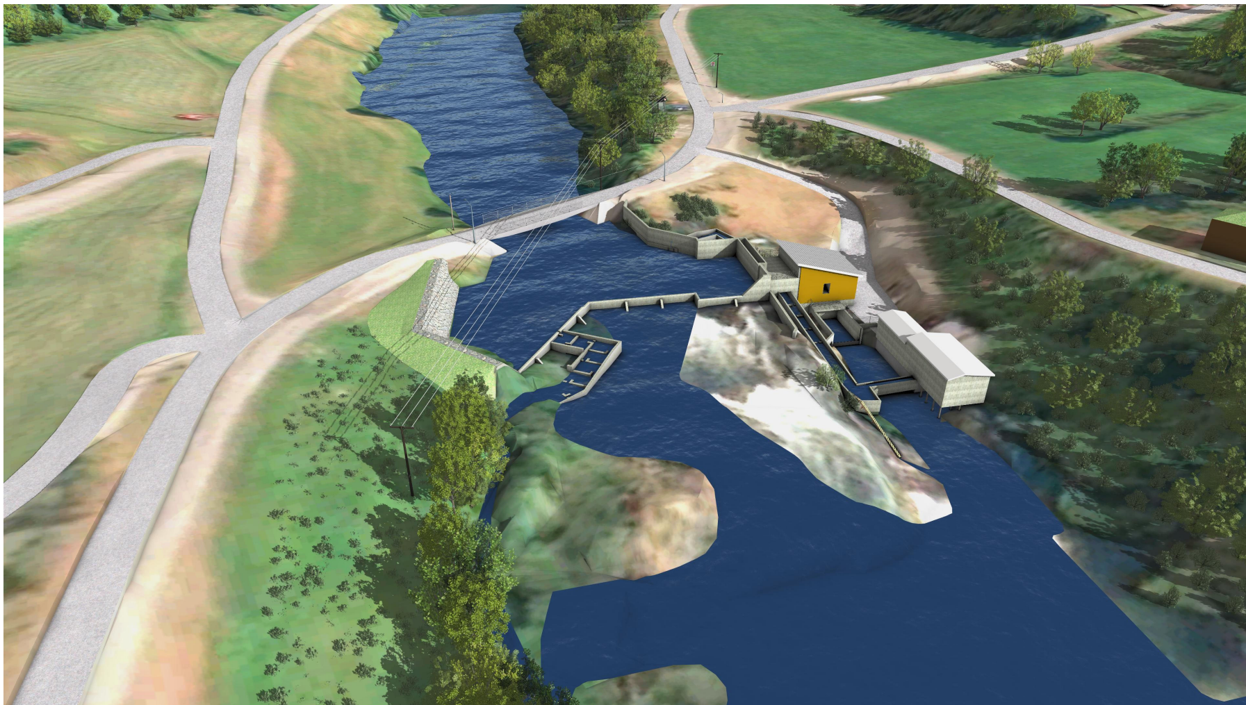
Tiltaksområdet ved Evebøfossen, mot oppstrøms/aust
