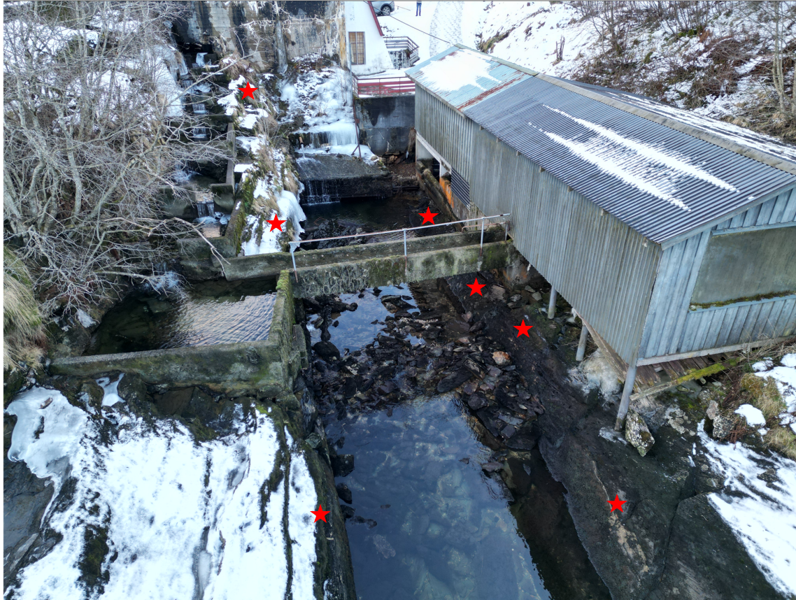
Bilde 1: Vestleste del av tiltaksområdet med eksisterende utløpskanal og kraftstasjon midt i og øvst i bildet, klekkeriet kan sjåast til høgre i bildet. Raude stjerner viser område med fjell i dagen. Bildet er teke frå vest mot aust.
