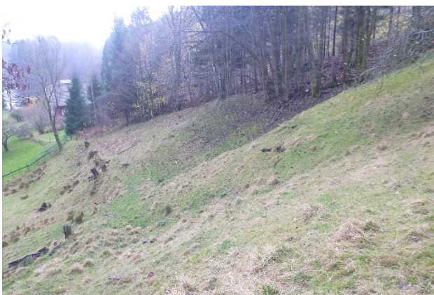
Figur 13: Skråning der det har vært setninger. Merk stubber fra trær som har stått der tidligere og som er hugget.
