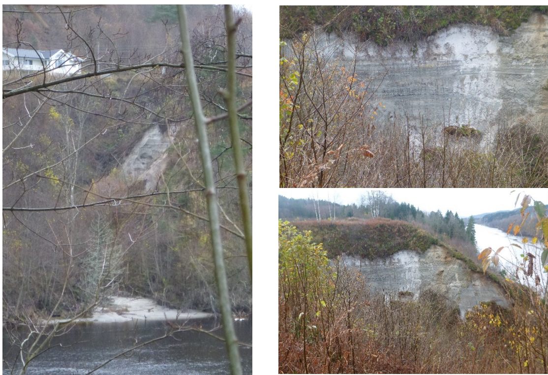
Figur 12: Overflateskredet i sonen "Dyrskueplassen". Overflateutglidningene fortsetter videre parallelt med elven. Merk de tydelige, horisontale avsetningshorisontene i den marine leiren og den svært finkornede sanden som ligger over.
