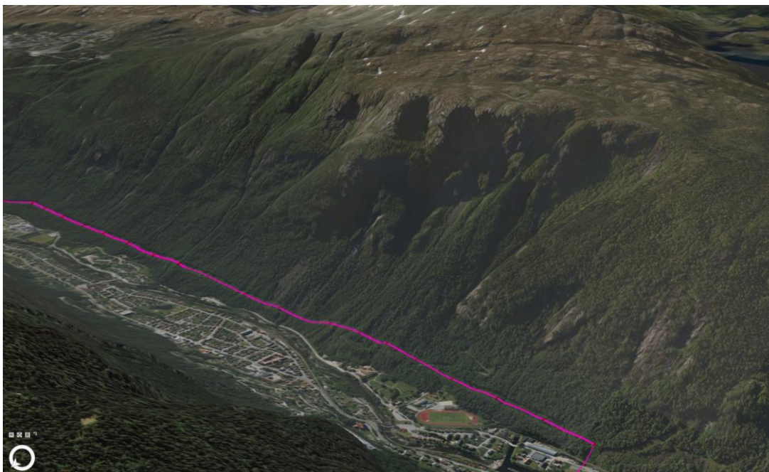
Figur 2-12: 3D-bilde av mastetraséen som viser skredavsetningene nedenfor de store, sammenhengende og bratte fjellsidene. Sett mot sør-øst.
