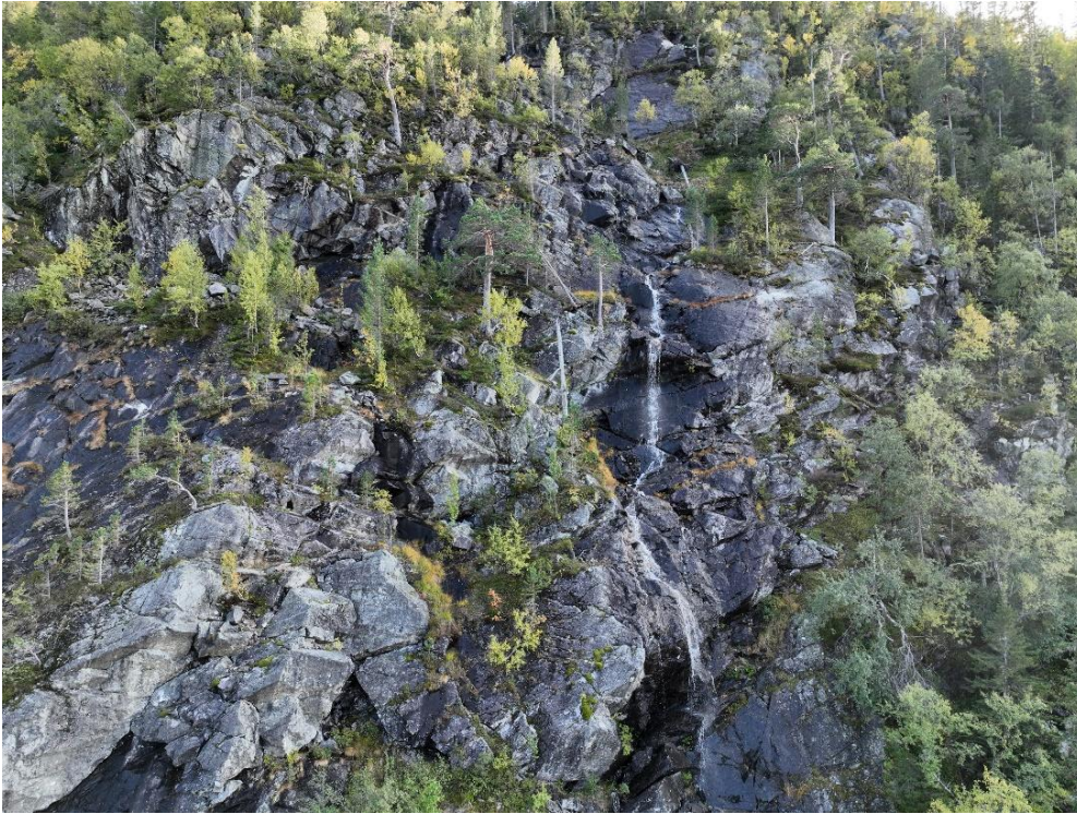
Figur 2-23: Nærfoto av løснеområde i øvre del av fjellsiden ovenfor M1. Det er flere potensielle avløste parti med løsnesannsynlighet større enn 1/100.
