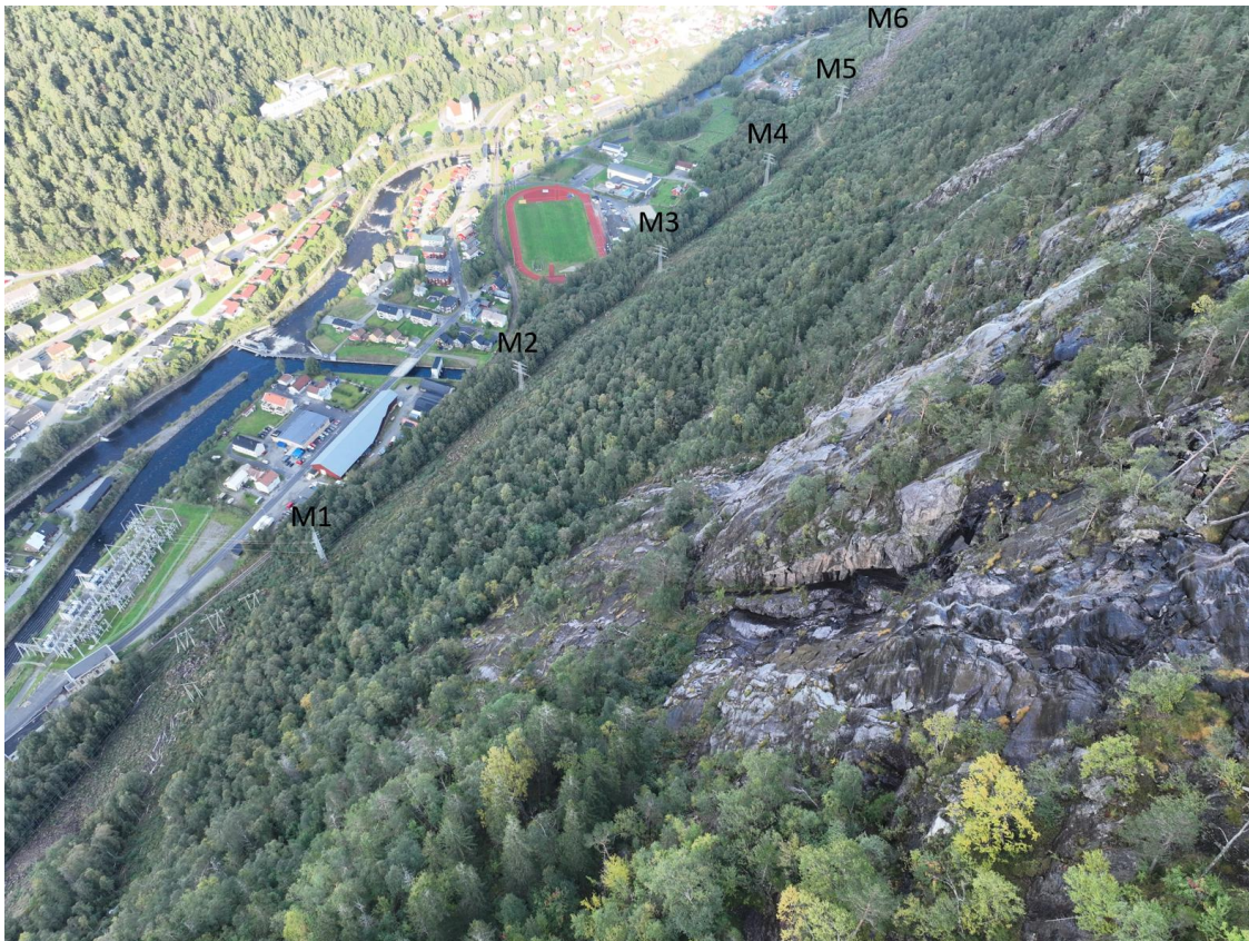
Figur 2-20: Fjellsiden ovenfor mastepunkt M1 – M6.
