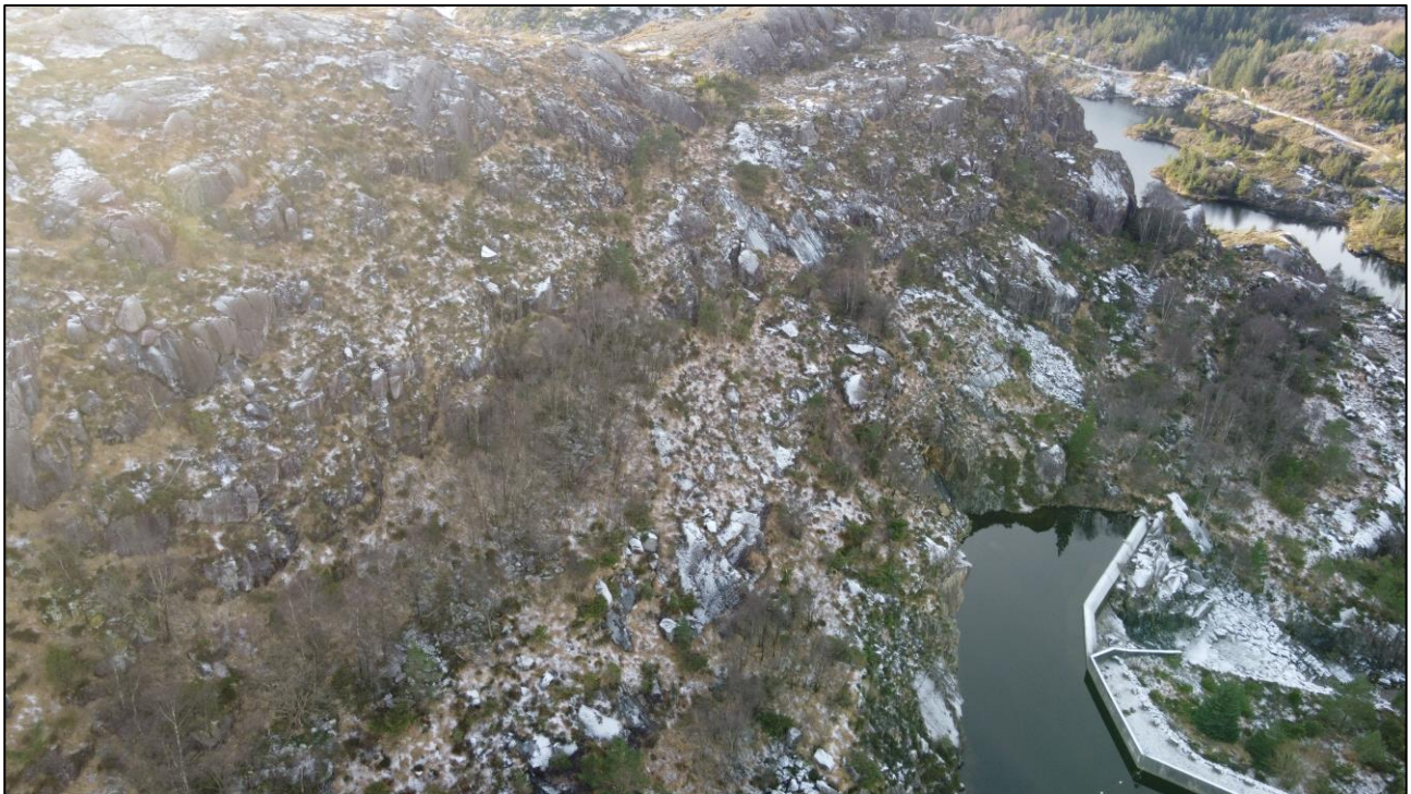
Figur 3-7. Dronefoto tatt i retning vest, med overløp og deler av dam Honnefoss til høyre. Terrenget stiger opp mot Hesten (181 moh.).
