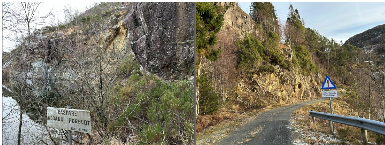
Figur 3-21. Fareskilt ved ved dam Honnefoss (til venstre) og ved adkomstvei til Honnefoss kraftstasjon (til høyre).
