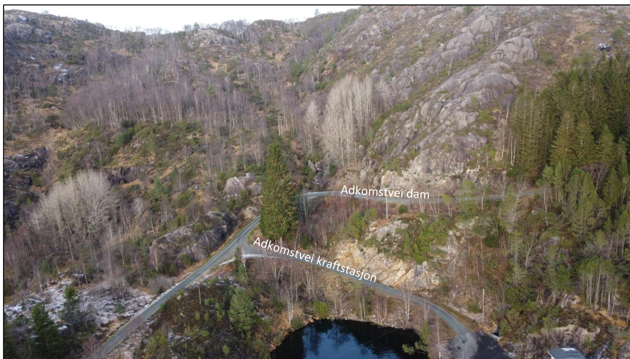
Figur 4-9. Dronefoto tatt i retning nord, som viser skjæringer/skrenter i bakkant av de to veiene.
