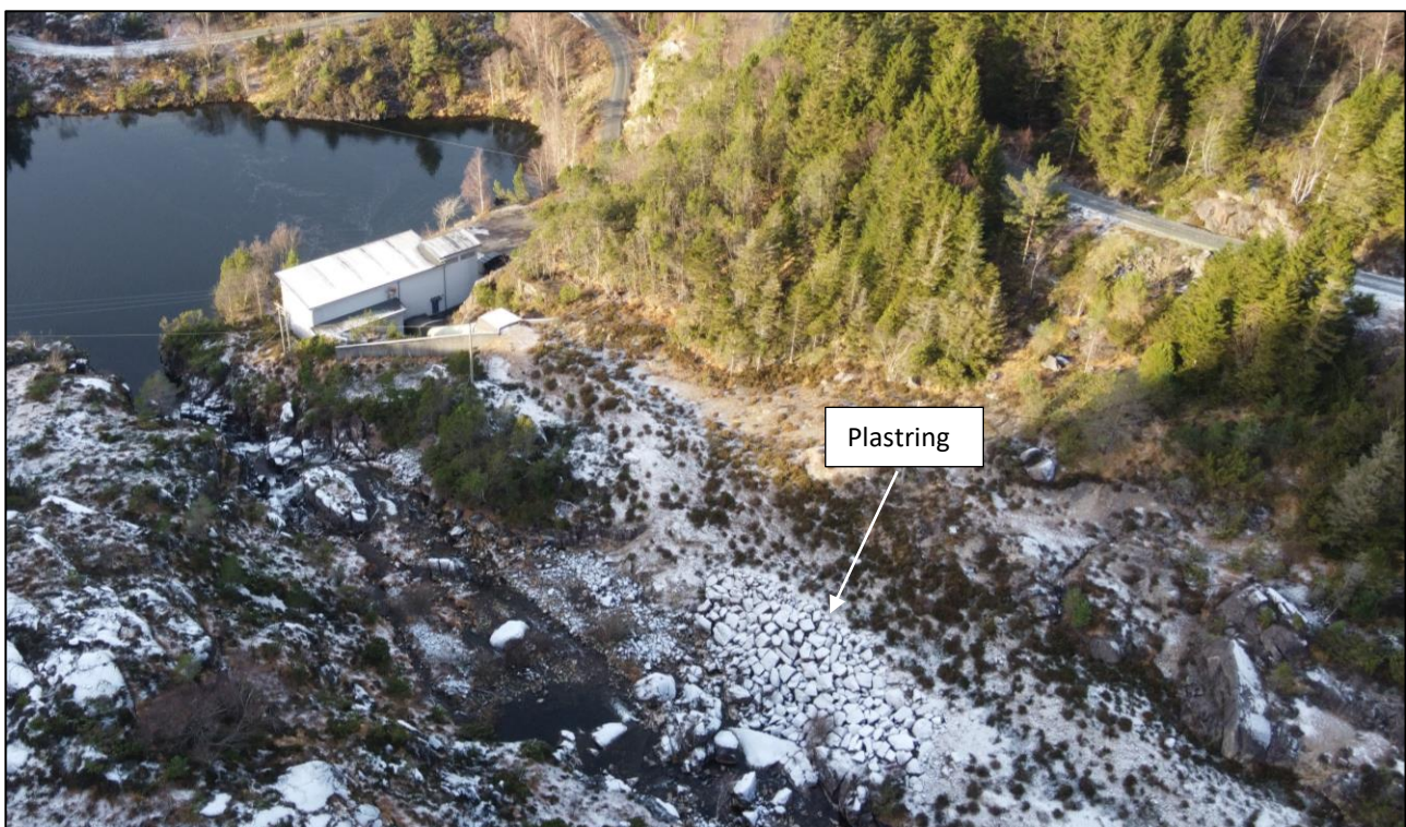
Figur 4-14. Dronefoto som viser én av to seksjoner av nedgravd rørgate hvor det er utført plastring.
