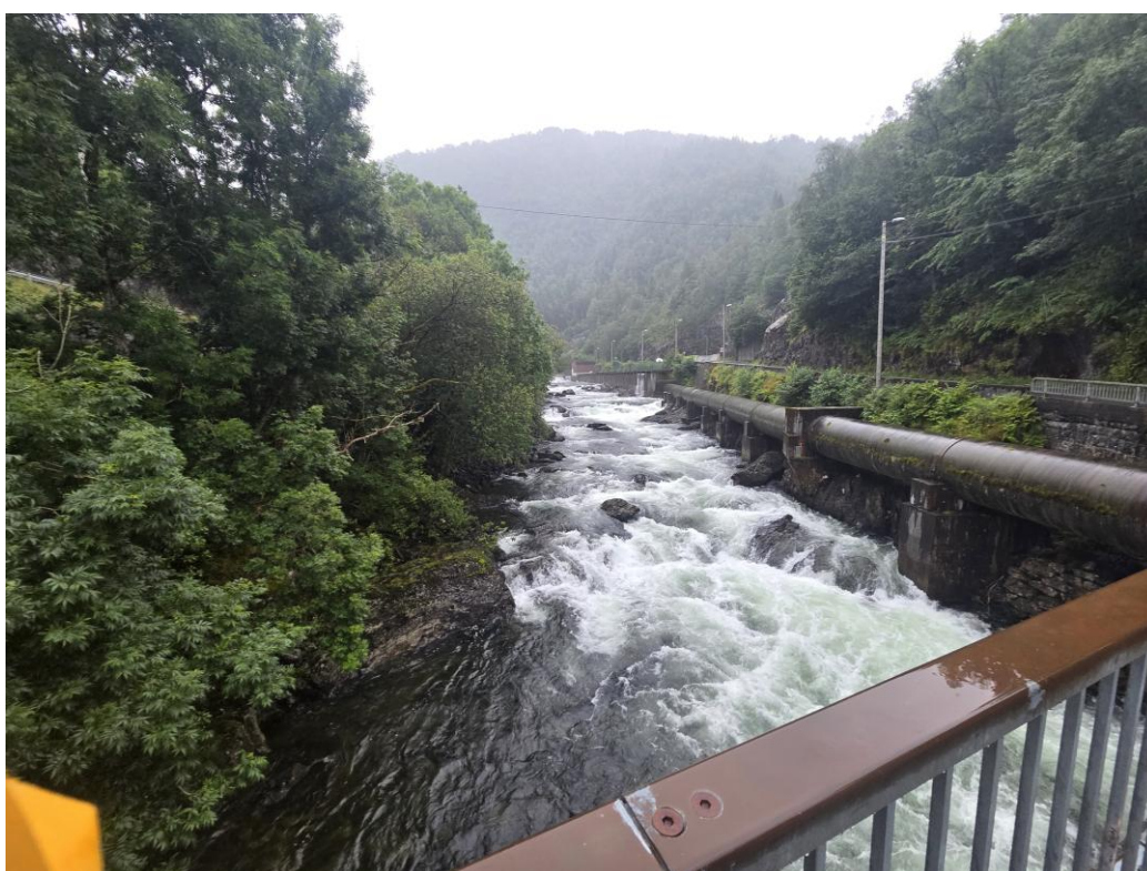
Figur 29. Bilde tatt: 04.08.2025 kl 19:37. Målt vannføring fra minstevannføringsstasjon Tyssefossen: 15,0 \text{ m}^3/\text{s} . Foto: Sweco.
