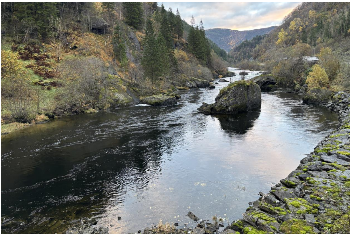
Bilde 22 Tysseelva mellom Frølandsvatnet og inntaket til Tyssefossen kraftverk. Foto: Sweco.
