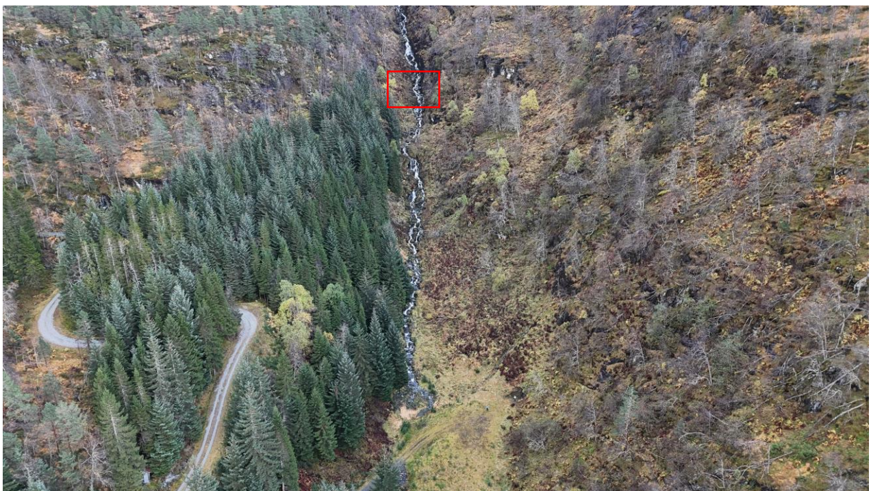
Bilde 6 Bildet viset bekken i Tverrligjelet. Eksisterende tverrslag og tipp vises nederst i bildet. Plassering av nytt bekkeinntak er skissert i rødt. Foto: Sweco.
