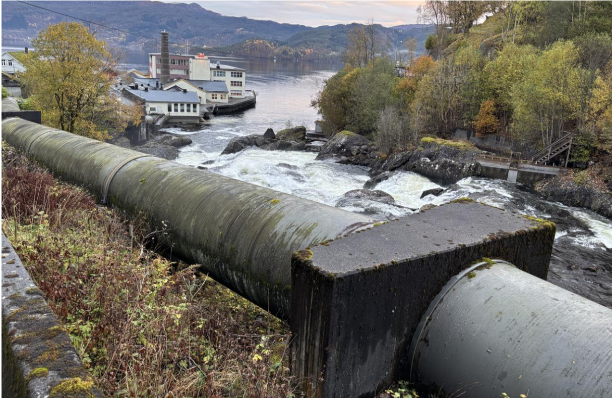
Bilde 23 Tysseelva ved utløpet i fjorden. Tilløpsrøret til eksisterende Tyssefossen kraftverk i forgrunnen. Topp av laksetrapp vises i bakgrunnen til høyre i bildet. Foto: Sweco.
