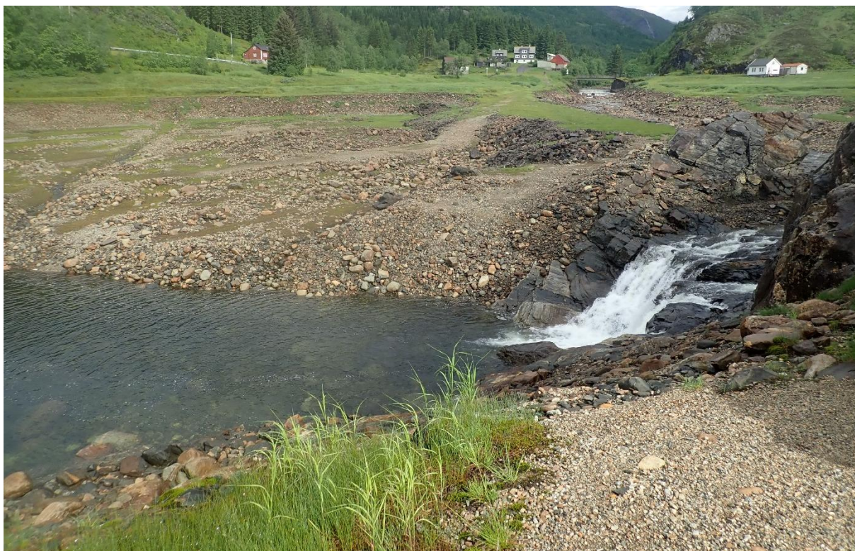
Figur 3-31 Utløpsområde for elva fra Klungerdalen ved lav vannføring, bilde tatt 29.05.2024. Foto: Sweco.
