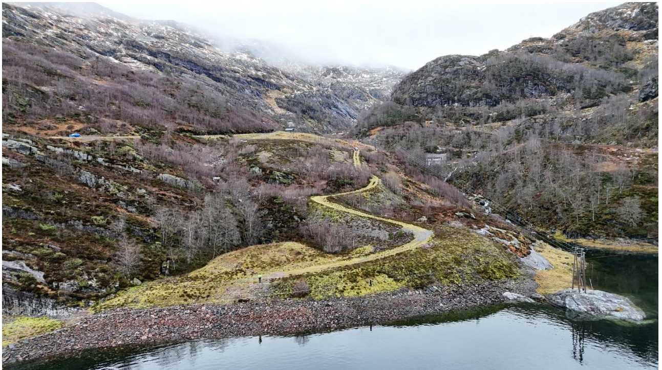
Figur 3-34 Utløpsområde for Dukaelva og eksisterende deponi for tippmasser, bilde tatt 27.12.2024. Foto: Sweco.
