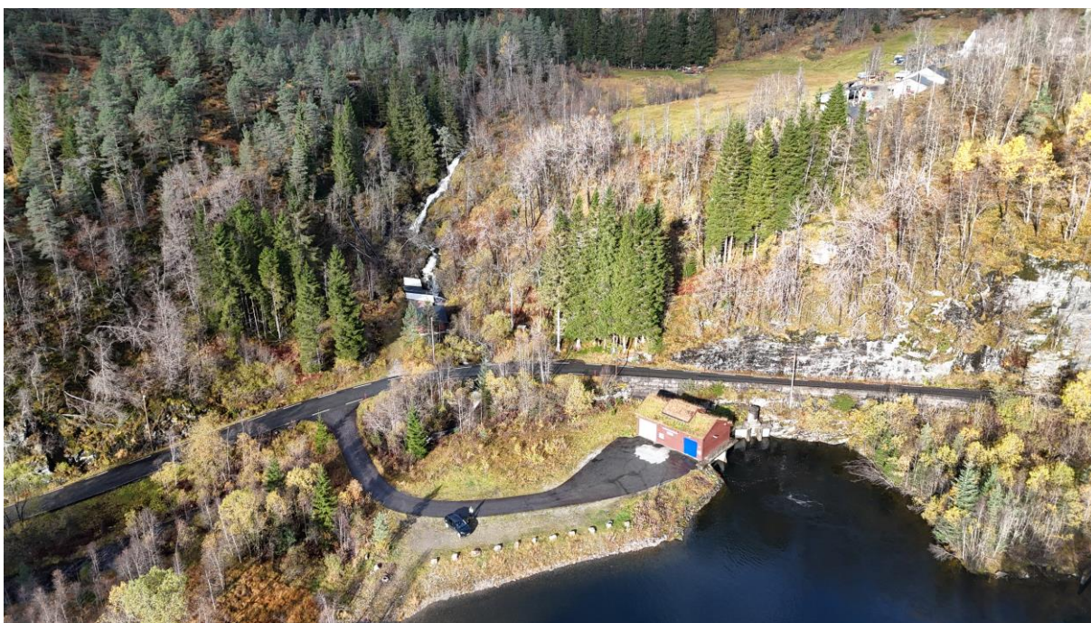
Bilde 12 Bildet viser eksisterende Myra kraftverk. Påhugg til rømningstunnelen til Børdalen kraftverk kommer på oversiden av vegen. Foto: Sweco.
