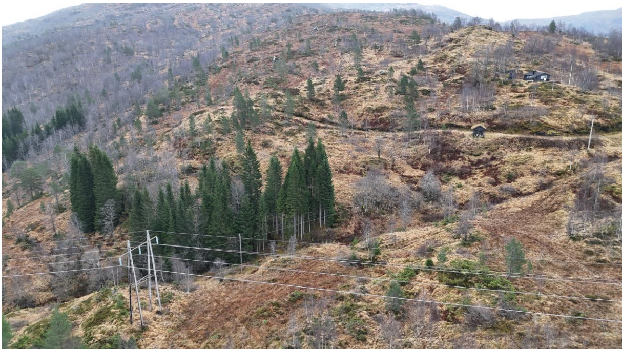
Bilde 14 Bildet viser plassering av svingetunnel og massedeponi på Leitet. Påhugget kommer like bak granfeltet. Deponiet plasseres i søkket ved og nedenfor granfeltet (bak høyspentstolpe). Ny adkomstveg vil følge eksisterende veg forbi gapahuk, og svinge seg ned til påhugget. Foto: Sweco.
