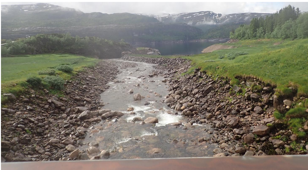
Figur 3-36 Utløpsområde for elva, sett mot sør fra veibrua, fra Klungerdalen ved lav vannstand og lav vannføring, bilde tatt 27.12.2024. Foto: Sweco.
