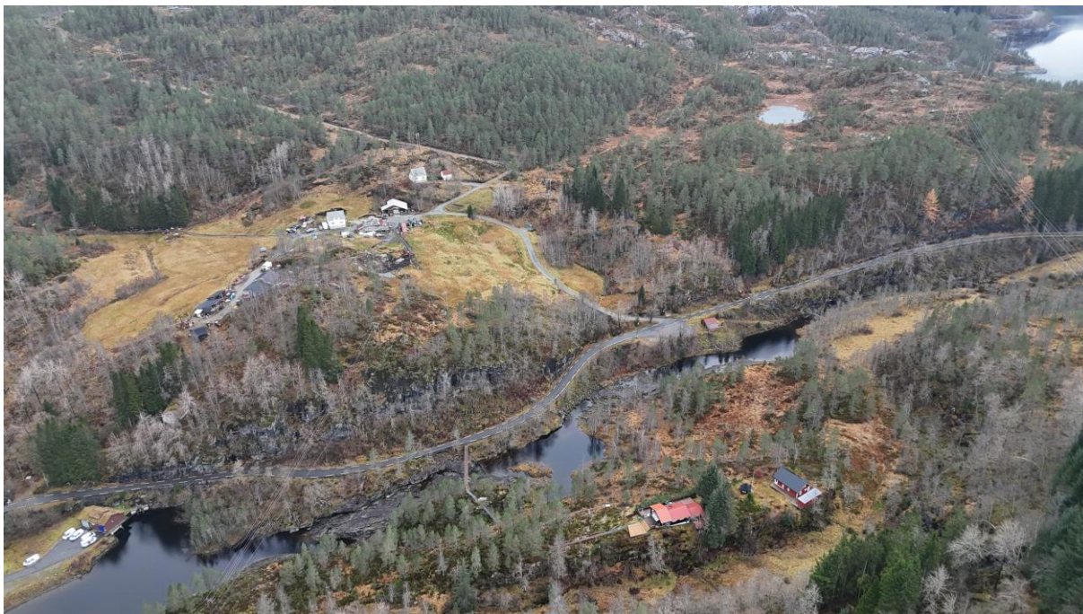
Bilde 11 Oversiktsbilde av nedre del av elvestrekninga Grønsdalsvatnet-Fiskevatnet. Omsøkt påhugg for rømningstunnel vil komme nederst til venstre i bildet. Foto: Sweco.
