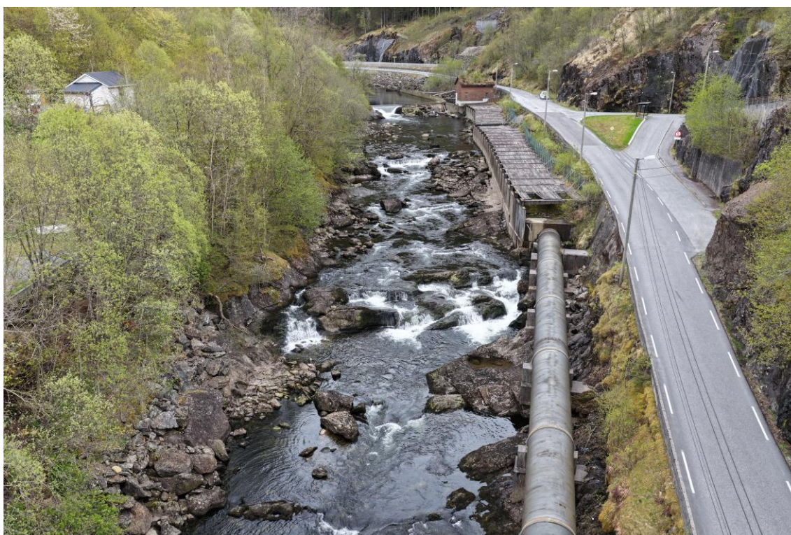
Figur 27. Bilde tatt 12.05.2026 kl. 16:11. Målt vannføring basert fra minstevannføringsstasjon Tyssefossen: 1,8 \text{ m}^3/\text{s} . Foto: Eviny
