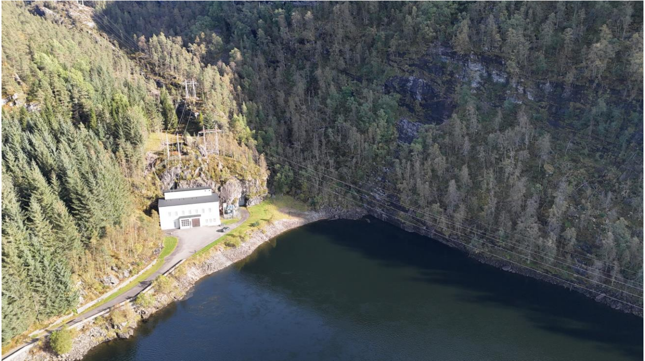
Bilde 7 Bildet viser Grønsdal kraftverk ved Grønsdalsvatnet. Nytt tverrslag etableres i bergveggen til høyre for eksisterende fylling. Det etableres nytt massedeponi i vika. Foto: Sweco.
