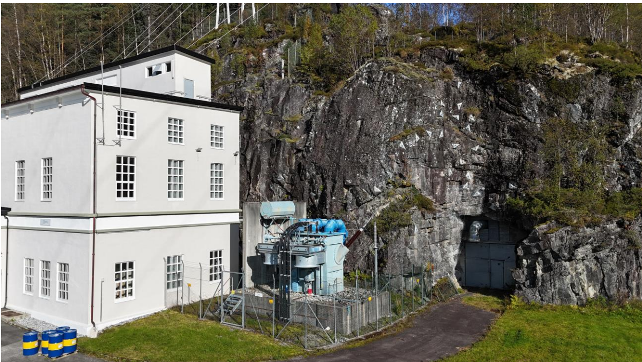
Figur 30. Skrent/skjæring bak Grønsdal kraftverk. Det observeres spredt bergsikring, med hovedvekt av sikring over påhugg til tunnel/bergrom.
