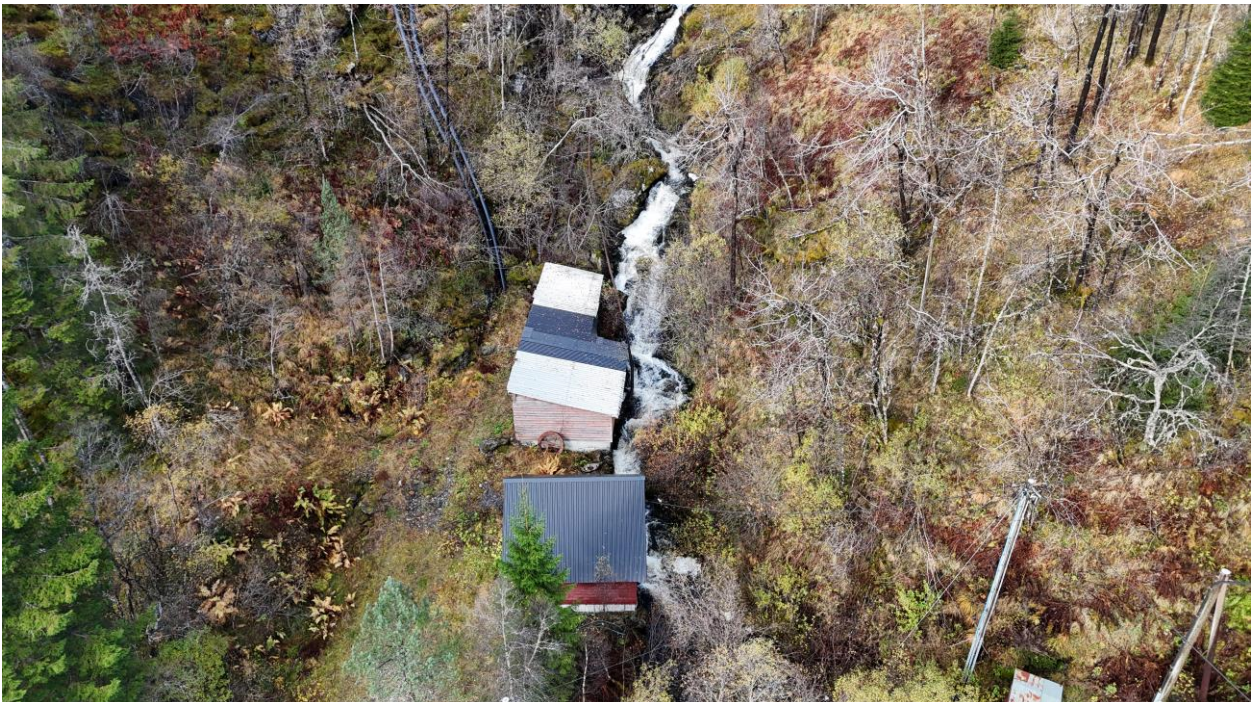
Figur 55. Bekk som drenerer gjennom utredningsområdet og ned mot Fiskevatnet.
