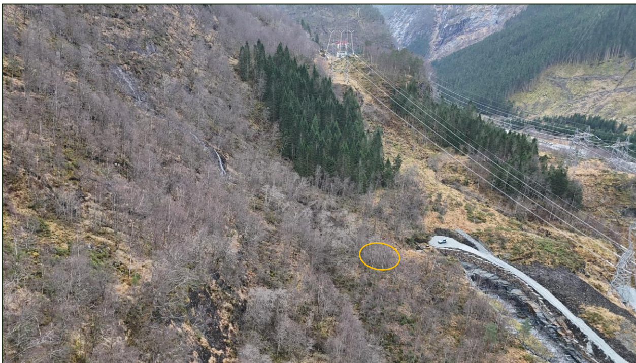
Figur 69. Bekkeløp med trolig flomvifte i bunn, plassering av vifte ligger ca. 90 meter nordøst for kartleggingsområdet og er vist med oransje sirkel.
