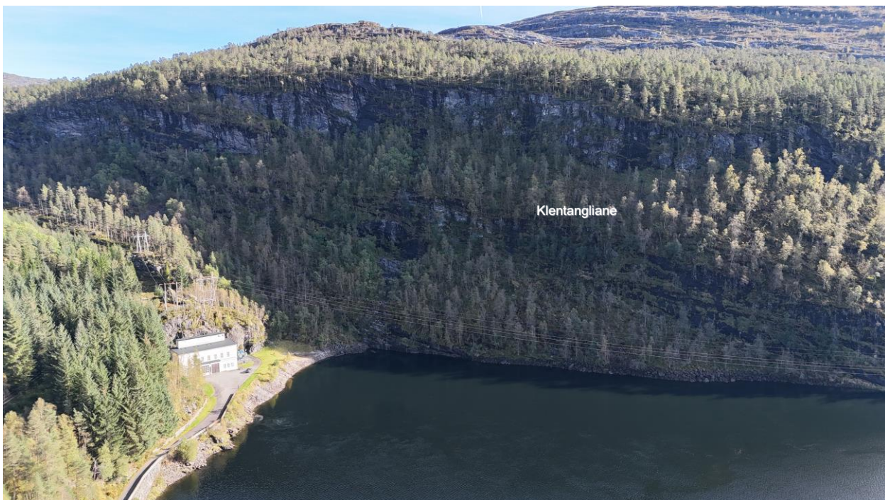
Figur 24. Grønsdal kraftverk og Kvitingvegen til venstre i bildet. Bratte skrenter oppover Kjentangliane. Ur i søkket/dalen mellom Kjentangliane og kraftverket. Bildet er tatt mot sør.
