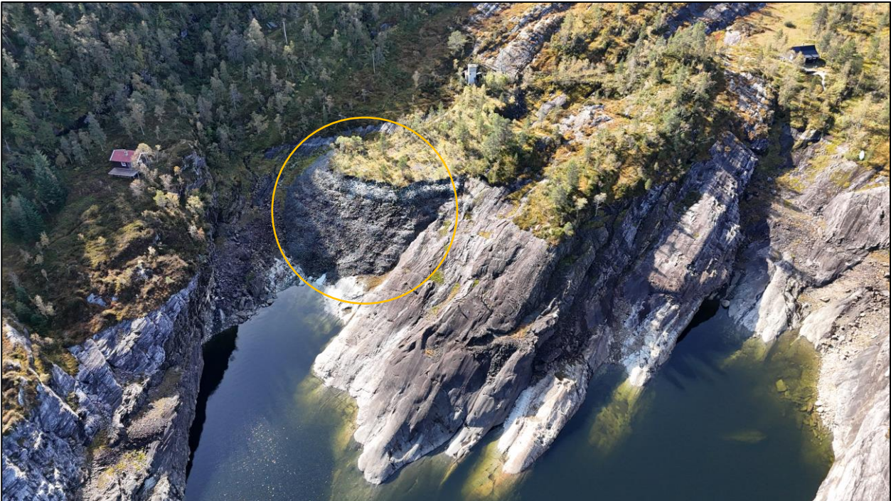
Figur 13. Tipp markert med gult. Til venstre for tipp er det blokkansamling nedenfor langs foten av bratte skrenter. Generelt mye bart berg i kartleggingsområdet. Bildet er tatt mot sør.
