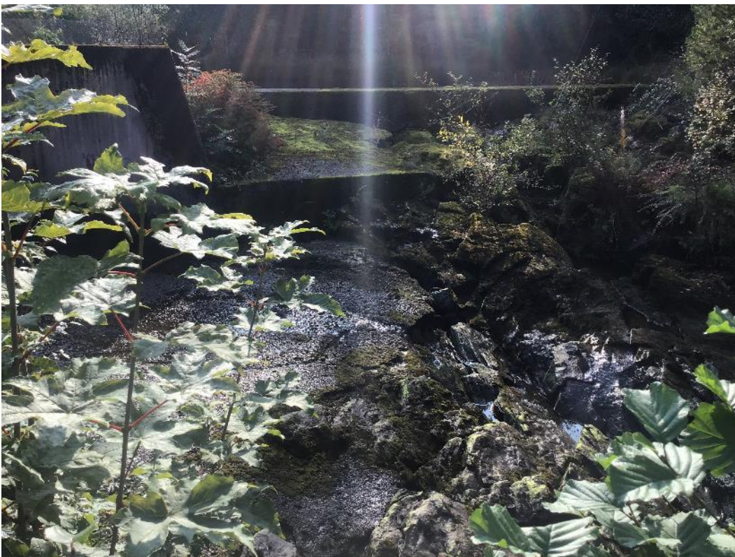
Figur 23. Reguleringsluka med tørt utløp ved stengning til venstre i bildet, og område der fiskepassasje for alternativ 2 kan være aktuelt i midtre del av bildet. Hvordan løsningen kan etableres må blant annet tilpasses tåleevnen til den eksisterende konstruksjonen.
