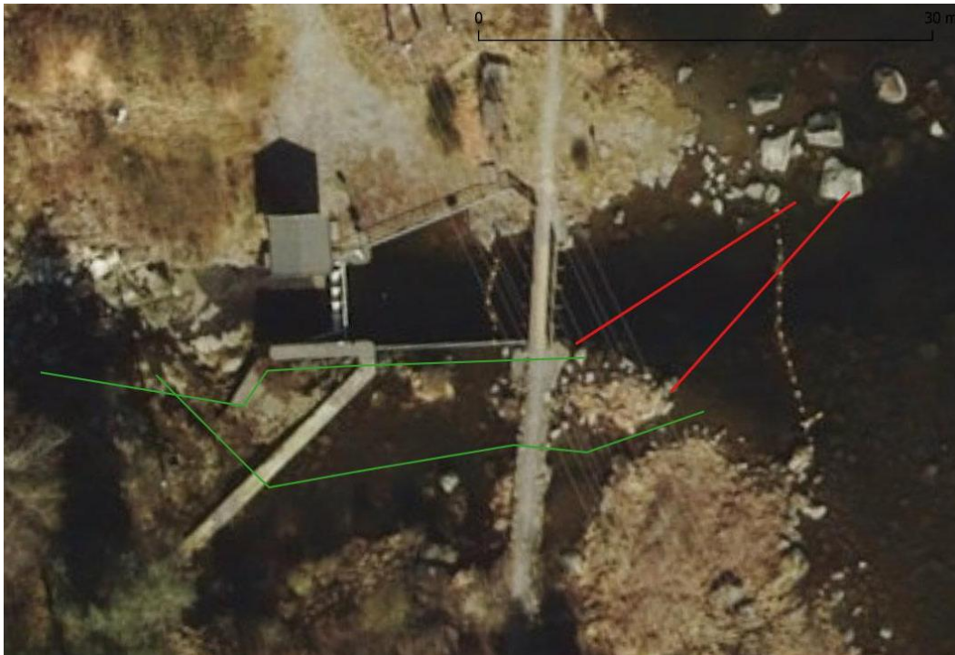
Figur 15. Grønne linjer er skisserte traséer for toveis fiskepassasje i søndre løp øverst i Tauåna. Hvordan passasjen kan etableres må blant annet tilpasses eksisterende konstruksjon og hva den tåler. Det er mye fall nedstrøms vestre, skråstilte betongterskel. Det er usikkert om det vil være mulig å etablere en naturpreget fiskepassasje som også fungerer for ål her. En finmasket rist eller en Louver-rist (røde linjer) bør trolig hindre fisken i å passere inn i reguleringsluka (og viktigst; lede fisken mot fiskepassasjen). Løsninger er her grovt skissert, og må detaljeres nøye.
