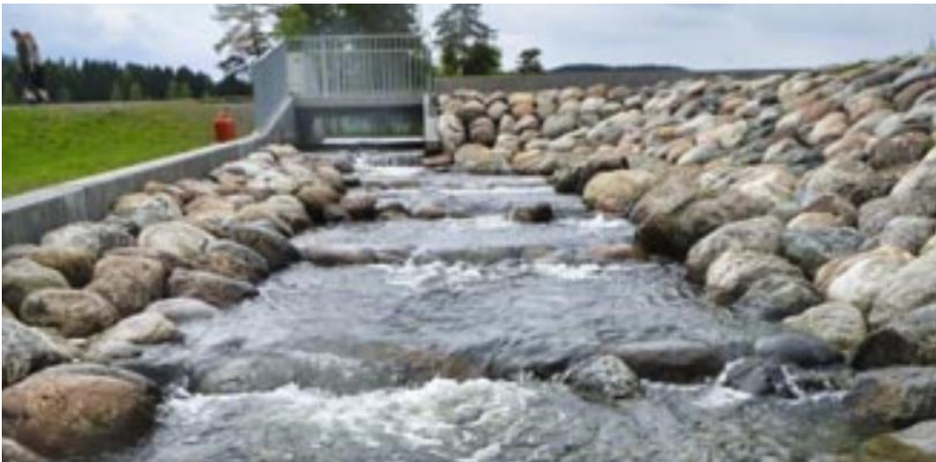
Figur 22. Eksempel fra Tiltakshåndboka (Pulg m.fl. 2023) på naturpregede småterskler på 10-15 cm og lavvansrenne, fra Sognsvann i Oslo. Dette løpet må også tåle flomvannføring.
