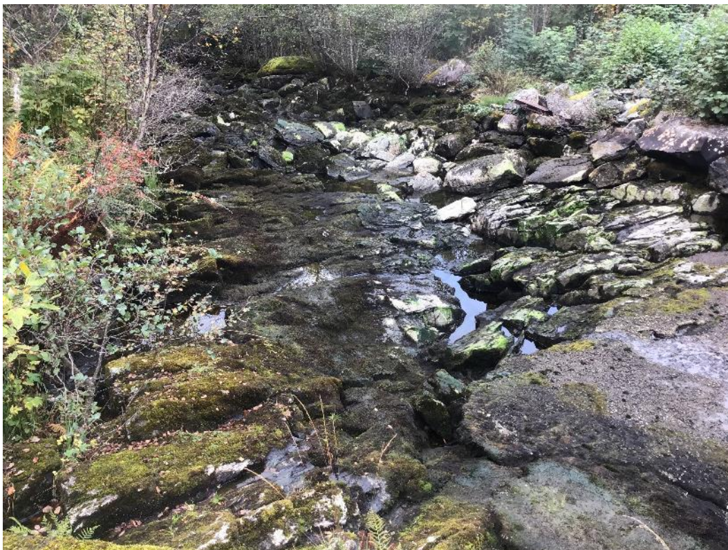
Figur 16. Etablering av fiskepassasje forbi eksisterende luke og dam må gjøres i område med grov blokk og berg. Plassering vil bli i venstre kant av bildet. Betongdekke i utløp under luke sees til høyre.
