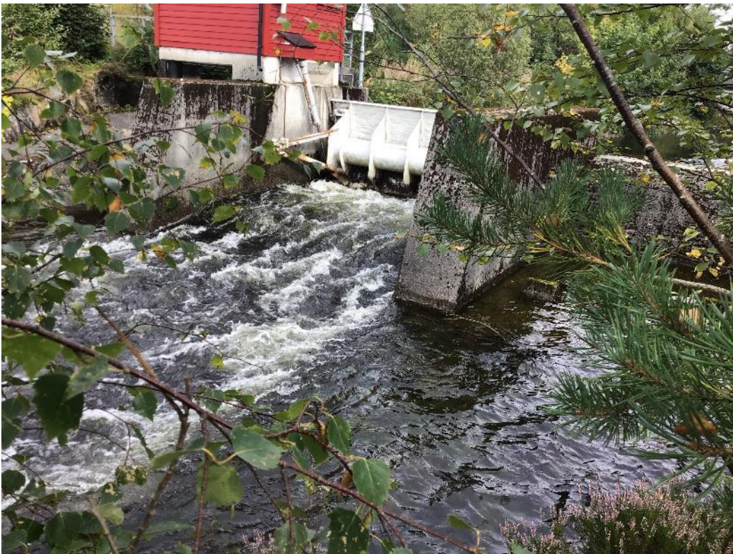
Figur 9. Luka ved utløpet av Tysdalsvatnet utgjør trolig delvis et vandringshinder når den er åpen, men strømforholdene framstår som mulige å passere for anadrom fisk av en viss størrelse. Når luka er i nedre posisjon utgjør den et vandringsstengsel (7-10 cm åpning). Bildet er fra 2. september 2024, og åpningen var ca. 60 cm og
