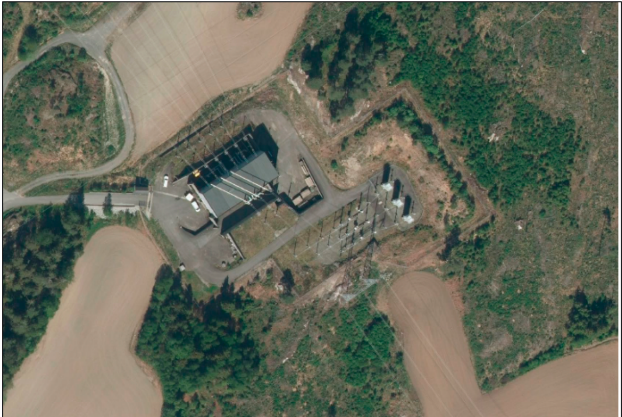
Kart 1: Satellittbilde som viser GIS-bygget og opparbeida areal inne på Tegneby stasjon i Burudveien 34 i Vestby. Kilde: Statnetts søknad av 29. september 2025.
