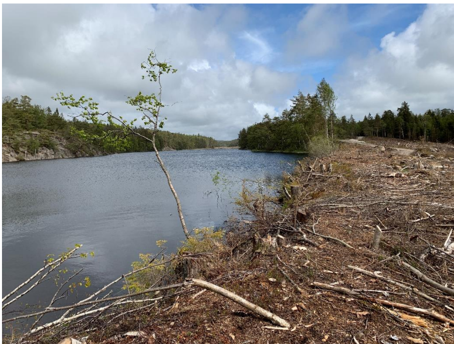
Figur 11. Bilde av Stordammen. Stordammyra i bakkant i bildet.
