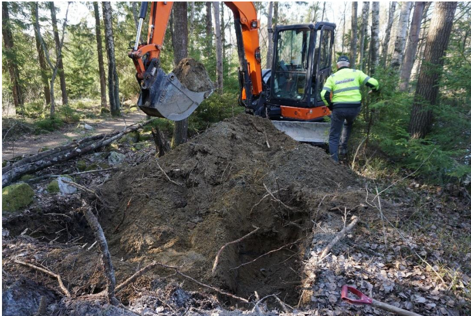
Sjaktning på sidedammen sett langs dammen med vannet på høyre side. Grusige sandige masser med stein i damkroppen. Nedstrøms mur synes til venstre.
