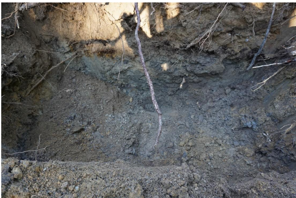
Sjaktning på sidedammen. Tettesone er synlig oppstrøms mot vannsiden. Prøve av massen ble tatt. Leirig materiale som siktekurve ovenfor.
