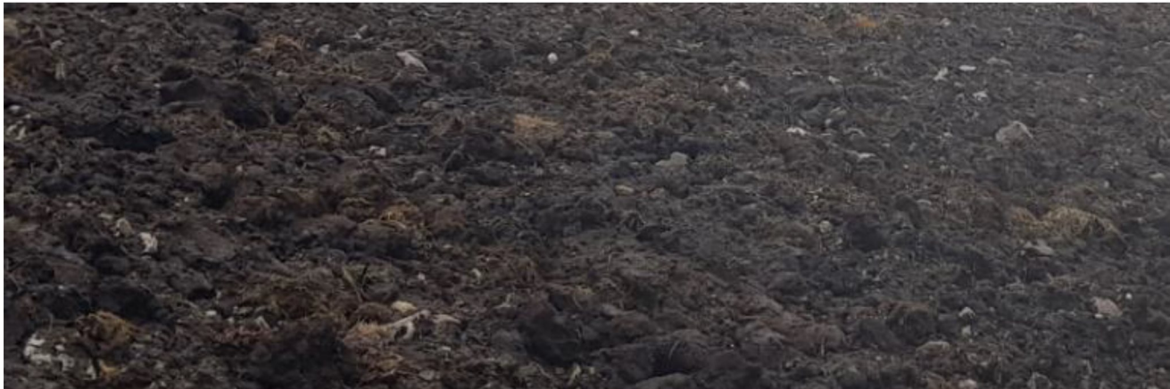
Figur 6 Masser som er lagt tilbake etter anleggsfasen. Toppmassene skal ha et rufsete utsende og ikke glattes til, da vil vegetasjon reetablere seg raskere med grunnlag i frøbanken fra den stedsegne floraen som finnes i jorda.
