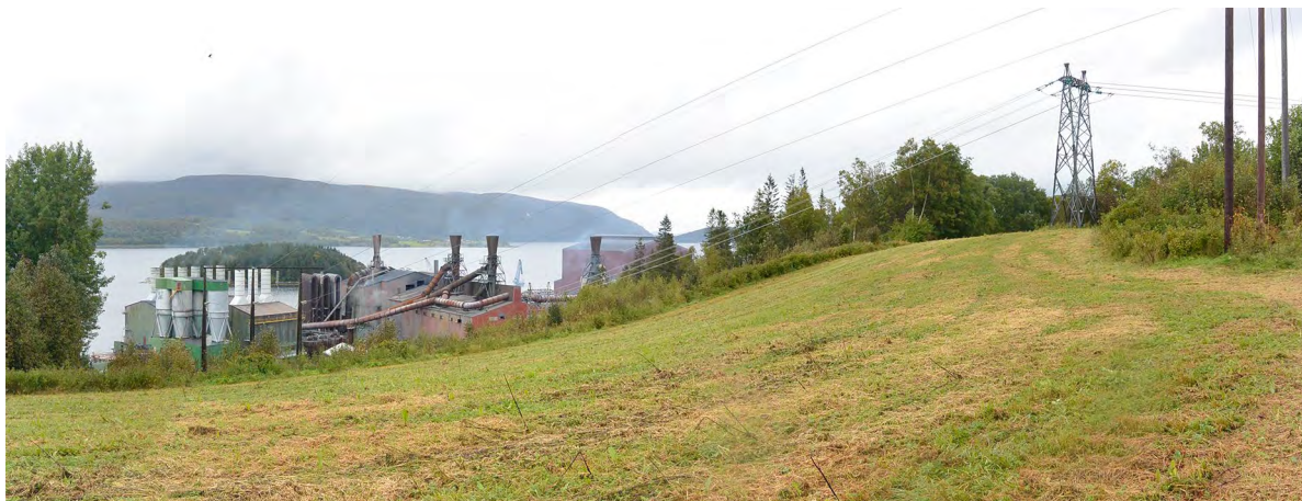
Figur 15: Dagens situasjon ned mot fabrikkbygget til Holla metall, der masten til høyre i bildet er plassert i og inn mot eksisterende kulturminne. Gravhaugen er tydelig arrondert i overflata og utgjør del av arealet som benyttes til beitemark.
