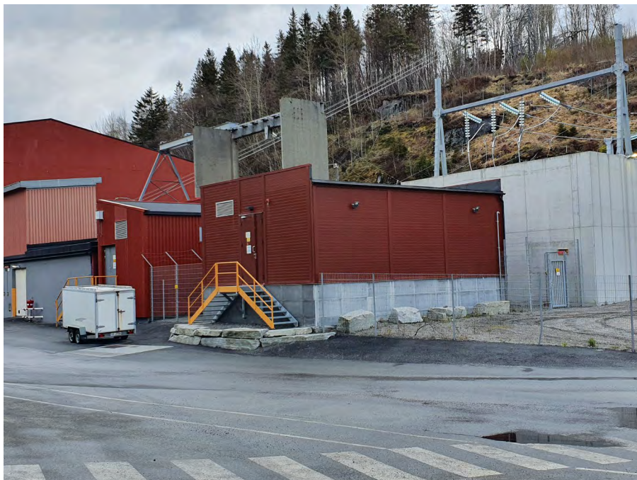
Figur 2: Eksisterende kontrollbygg for RT3 i rødt. Nytt kontrollbygg for RT4 vil plasseres til høyre i bildet, foran ny transformatorsjakt.
