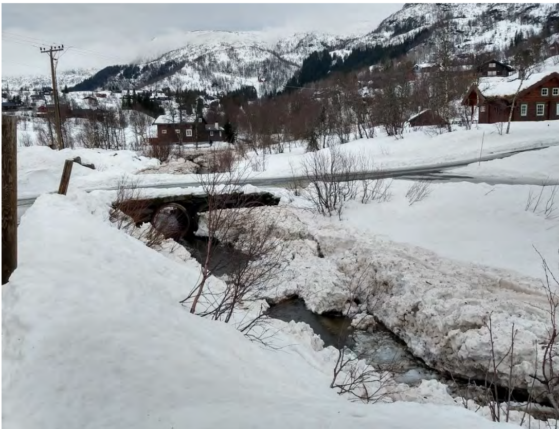
Figur 20: Bilde av snøoppdemming ved en kulvert i Røyro ved Dalen. Foto: Kvam kommune
