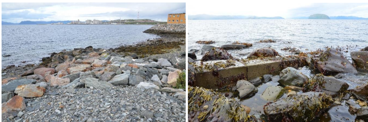
Figur 17 Utfylling for sjøkabel og vannforsyning til Melkøya. Mye stor strandsnegl ( Littorina littorea ) i nedre delen av strandsonen. Foto: D. Hammenstig, Akvaplan-niva august 2020.
