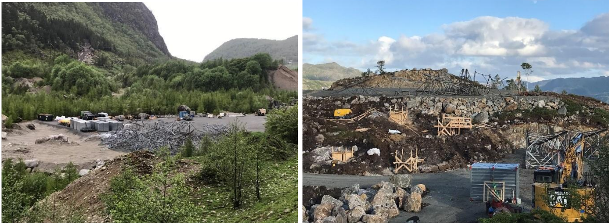
Figur 3 Typisk riggplass for premontering av master (til venstre) og forskaling og støpning av mastefundament (til høyre) Foto: Equinor.
