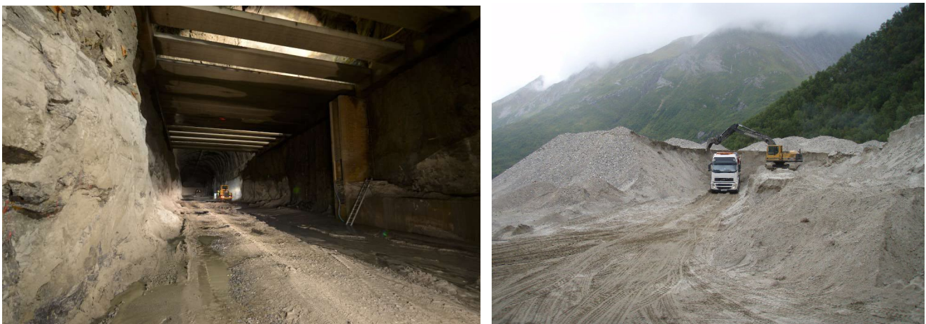
Figur 4.4 Sandfang ved Storjord og mellomlagring utenfor tverrslaget
