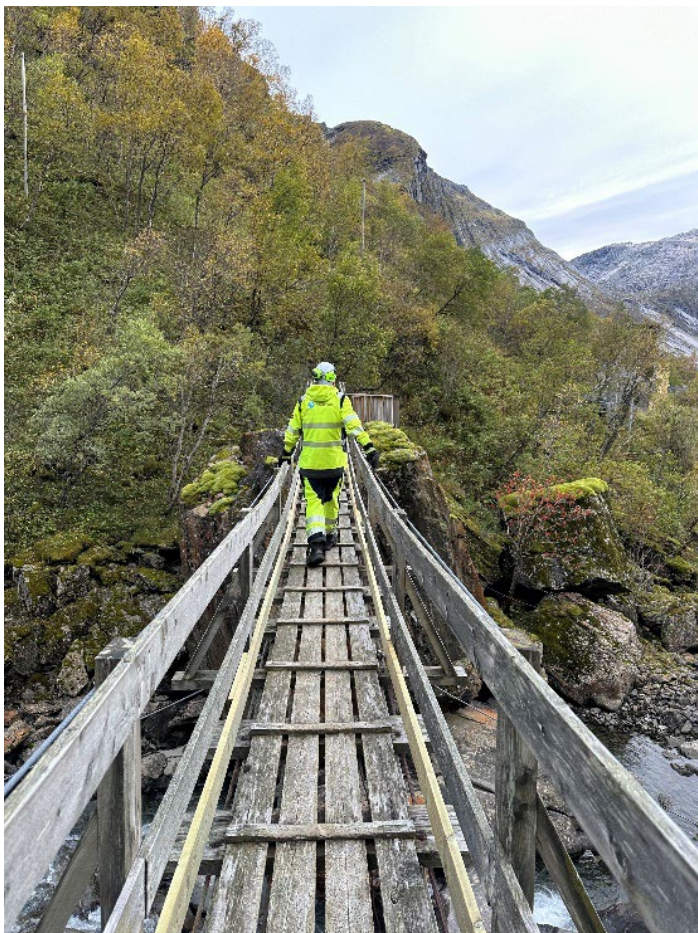
Figur 8.28 Bilde av hengebro over Fykanåga
