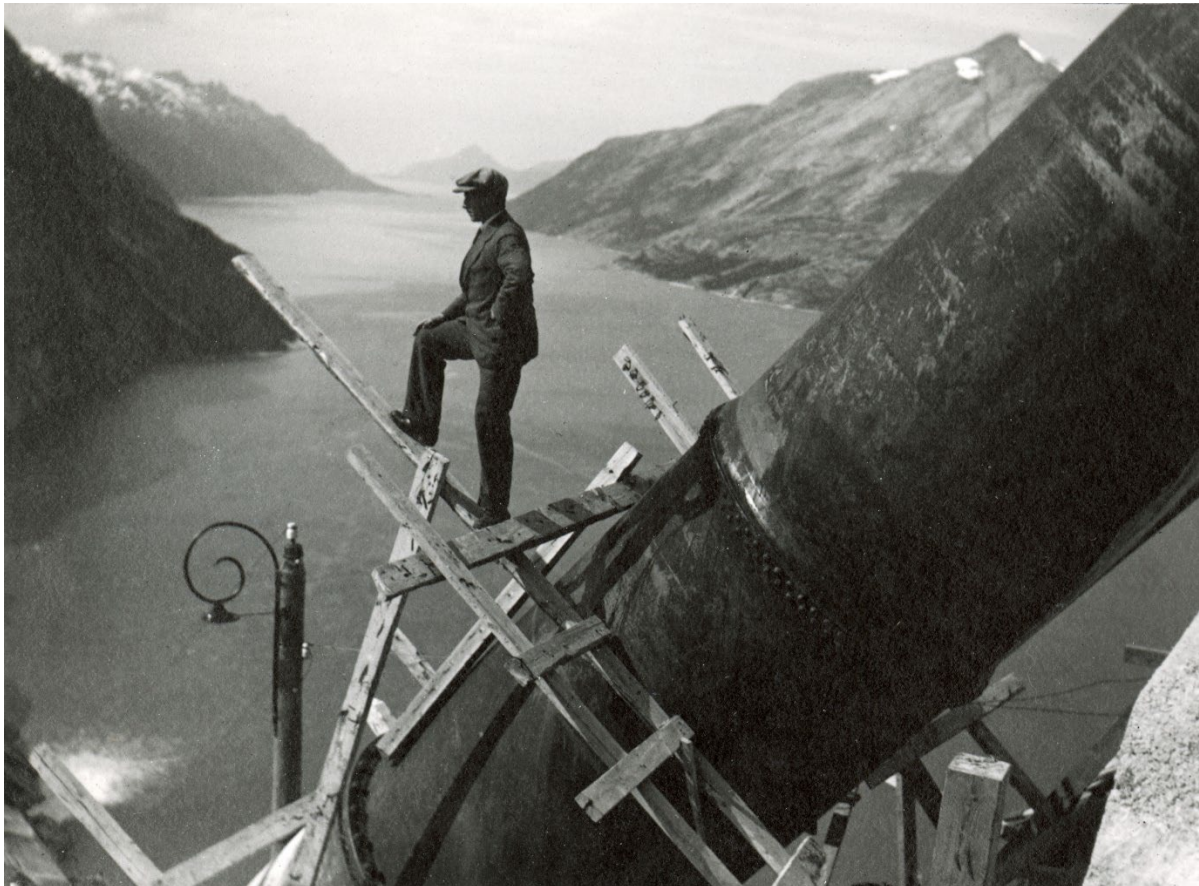
Figur 4.7 Inspeksjon av rørmontasje
