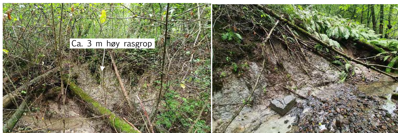
Figur 5. Bilder fra befaring den 28.07.2021
