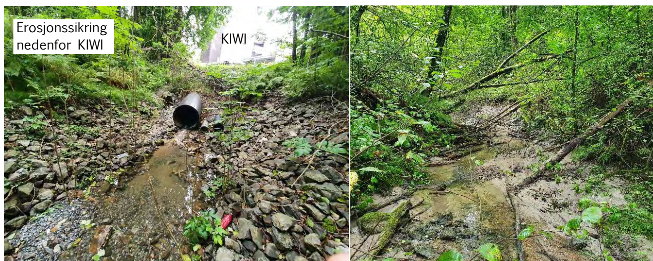
Figur 6. Bilder fra befaring den 28.07.2021
