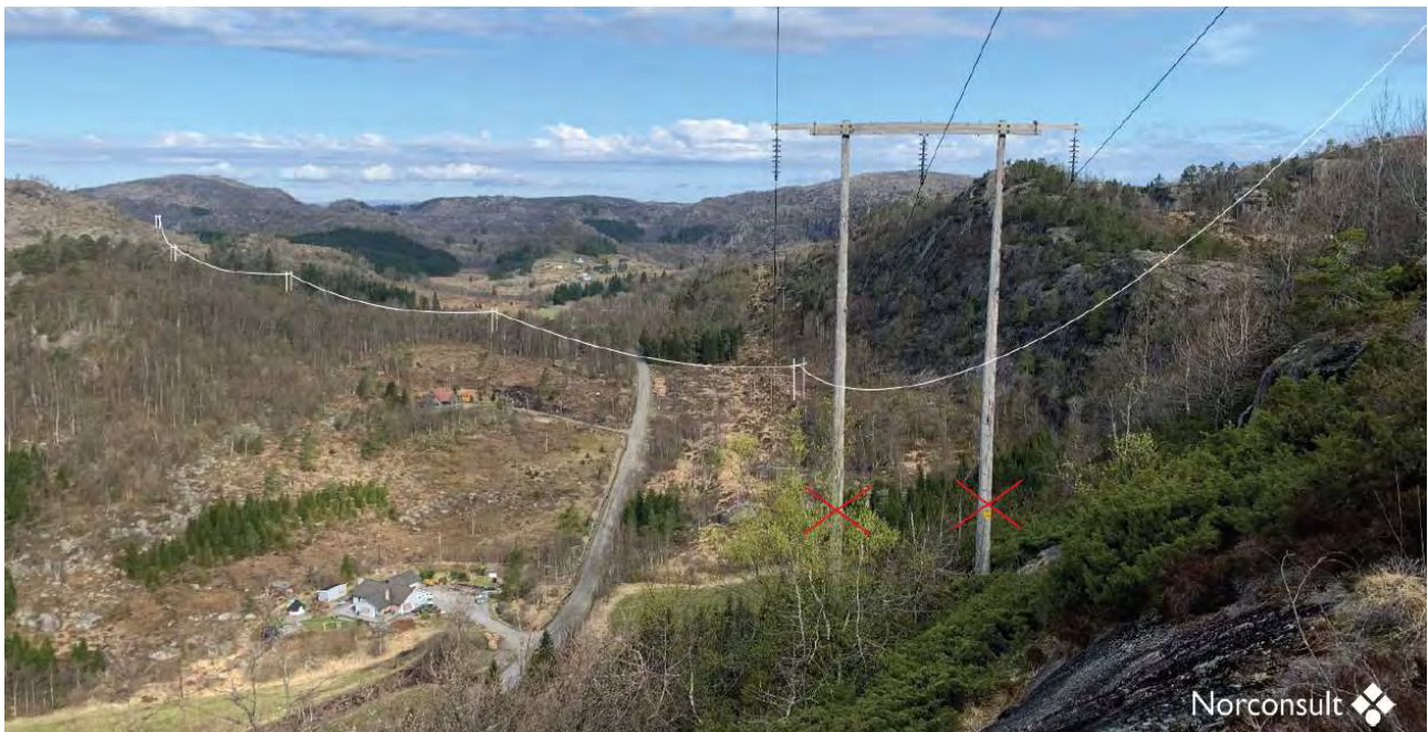
Figur 8-11. Strekskisse som viser alternativ 2.0 i Dragedalen sett vestover. Eksisterende mast i forgrunnen rives. Standpunkt 9.
