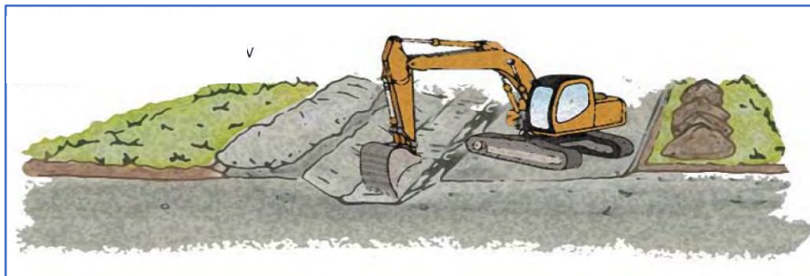
Figur 9-3. Massene som graves ut med gravemaskin legges opp langsmed kabelgrøfta.
