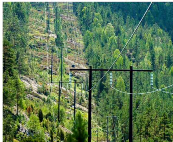
Figur 3-12. Rydding av skog i ledningstraseene gjøres i hovedsak med skogsmaskiner slik skogbruket driver i dag. Eksempel på ryddebelte langs kraftledninger.
