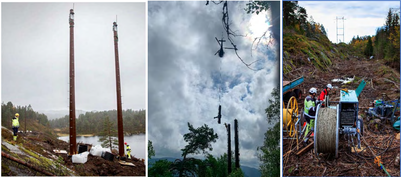
Figur 3-13. Mastene er heist på plass. Både kompositt og stålmaster leveres i brunfarge som i bildet til venstre. Etter premontering på riggplass flys mastene i deler ut til mastepunktet. Linene trekkes med vinsj (bilde til høyre) etter at pilotlinje er flydd ut med helikopter.
