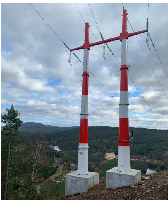
Figur 3-10. Eksempel på flymarkert mast med rød og hvit maling til venstre og master med refleks til høyre.
