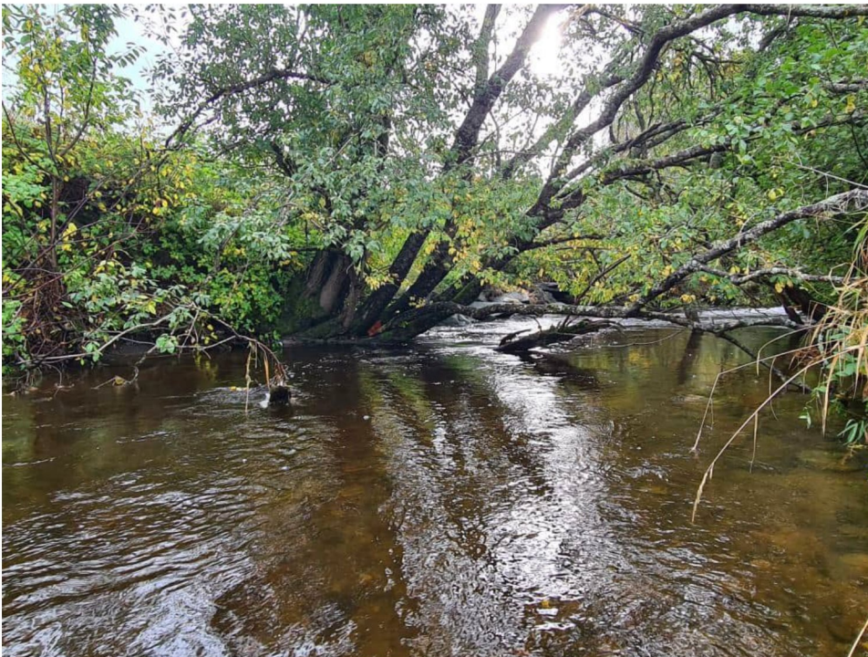
Figur 3-7: Punkt SV1. Trær på skakke og jevnt over noe erosjon. Eksisterende sikring ses bak i bildet. Bildet er tatt like øst for bru over Tolla vei.
