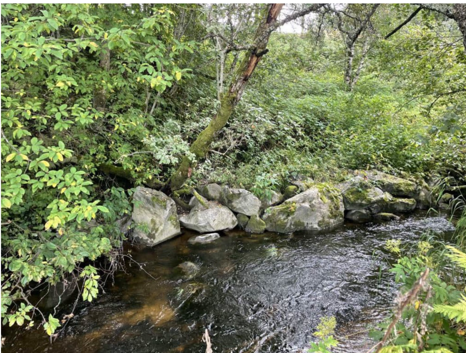
Figur 3-17: Punkt SV9. Sikring med stor stein nedenfor eiendom Tolla 1.
