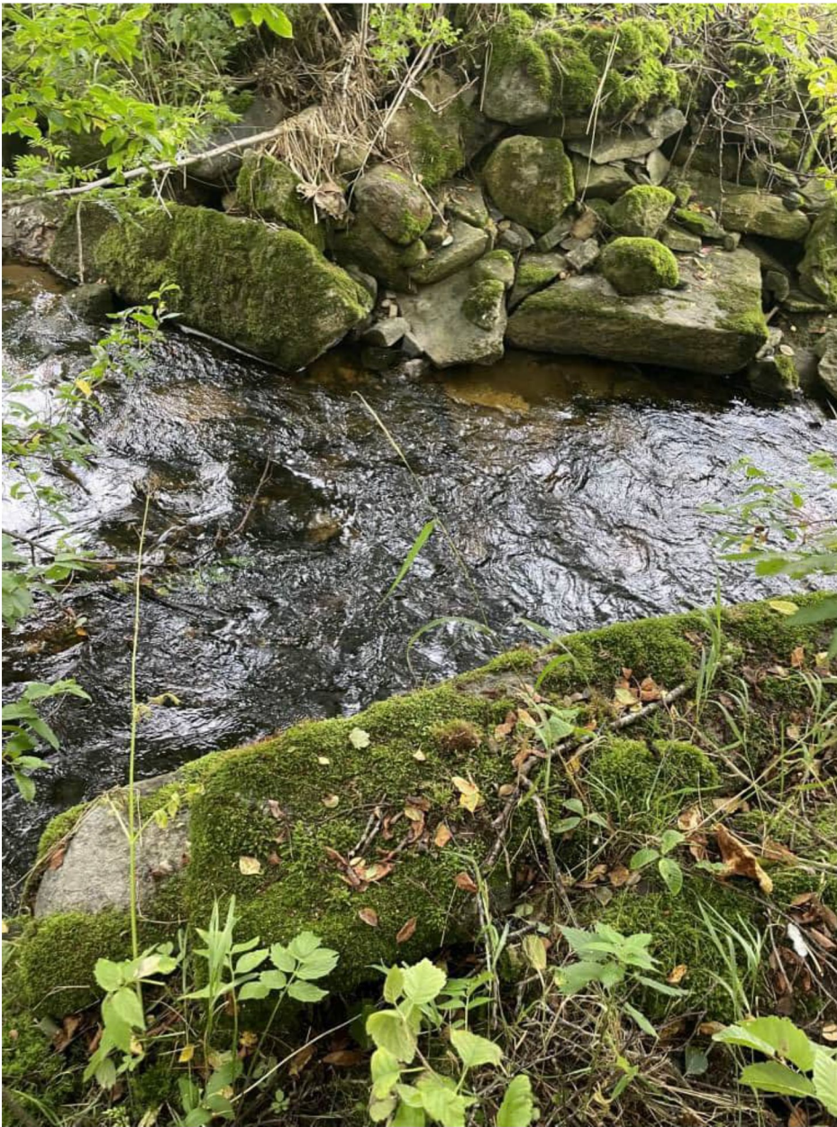
Figur 3-26: Punkt SM3. Gammel innsnevring som potensielt forverrer situasjonen nedstrøms.
