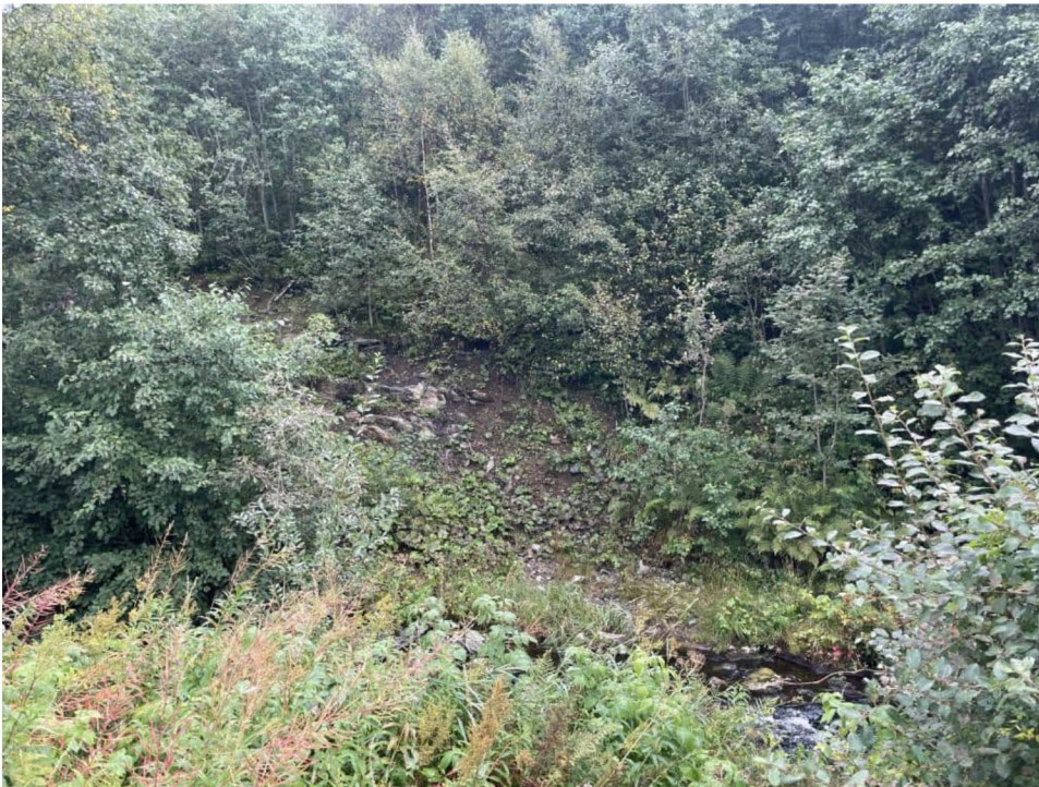
Figur 3-5: Punkt U4. Utglidning. Bilde tatt noe nedstrøms øverste bru over Ulkestadelva. Erosjon i skråningsfot har antakelig bidratt til utrasingen sammen med overflateavrenning.
