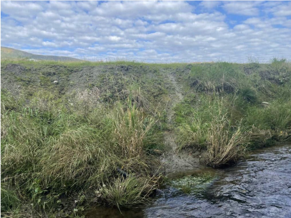
Figur 3-21: Punkt SM1. Erosjonskant med erosjonsriller, sett fra elva.
