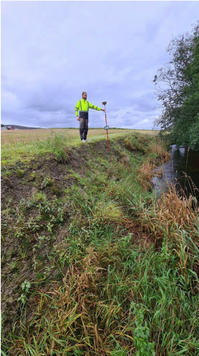
Figur 3-19: Punkt SM1. Erosjonskant i yttersving.
