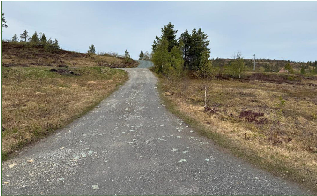
Figur 6: Vei over den bratte svingen sør for Dam Samsjøen må sannsynligvis slakes ut. Foto: Sweco.
