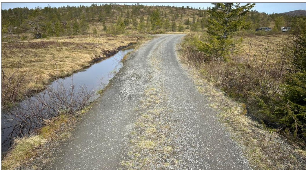
Figur 7: I dette området må dagens veikropp heves og utjevnes. Foto: TrønderEnergi Kraft AS.
