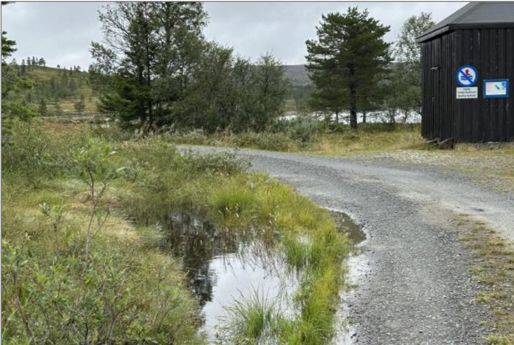
Figur 8: I dette området må dagens veikropp heves og utjevnes. Foto: TrønderEnergi Kraft AS.
