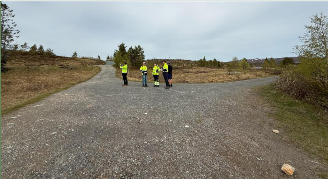
Figur 10: Bratt sving ca. 330 m sør for Dam Samsjøen. Foto: Sweco.
