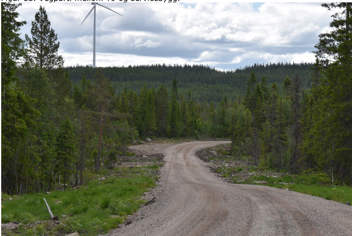
Figur 54. Vegparti mellom T9 og servicebygg.
