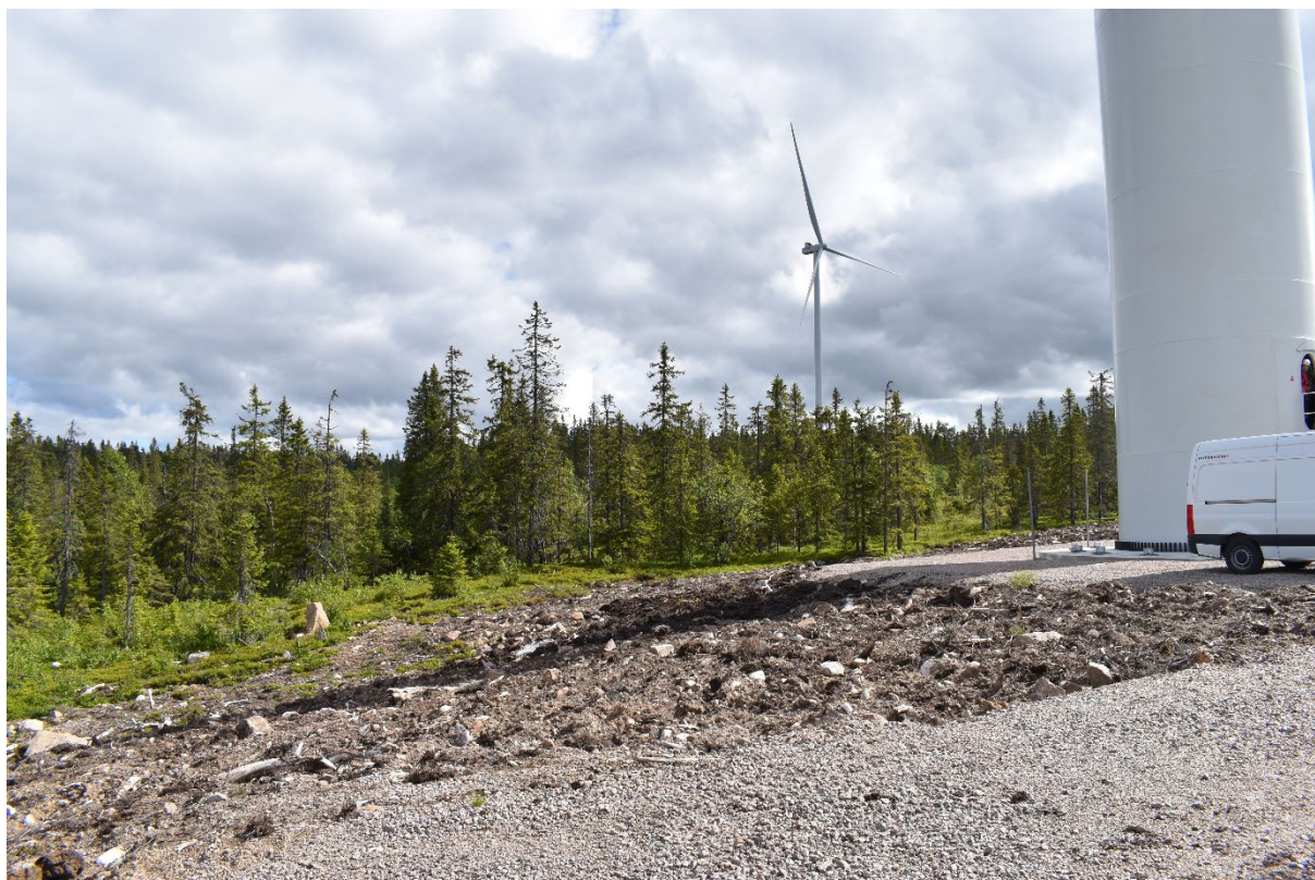
Figur 22. T4, turbinpunkt nordside.
