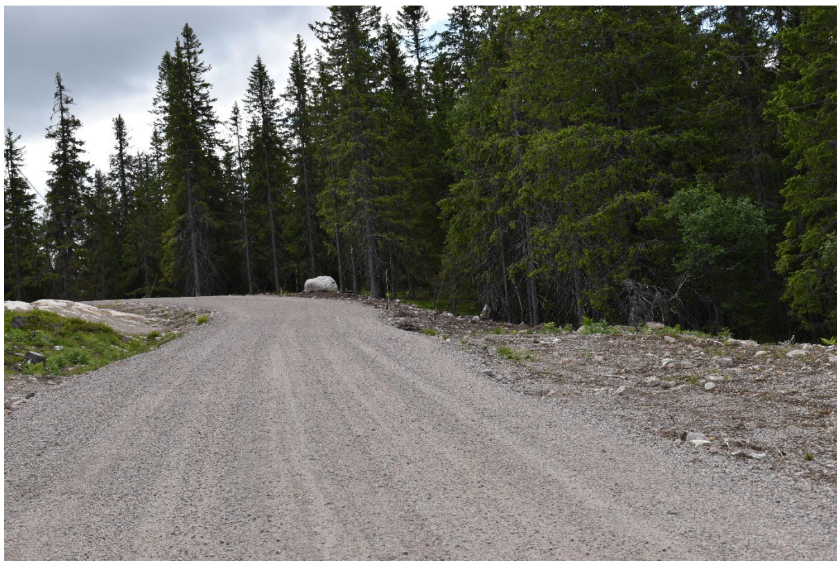
Figur 4. Vegparti mellom T1 og T2
