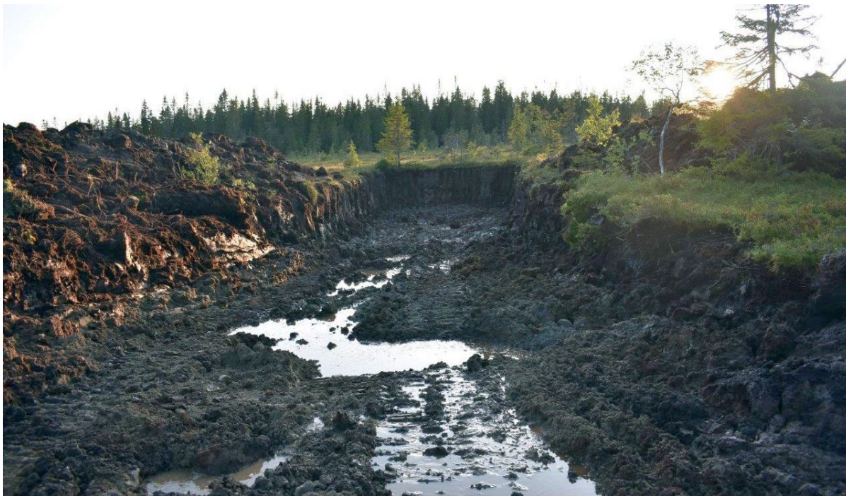
Figur 33. Myrkryssing mellom T5 og T6. Utgraving av myr i anleggsperioden. Ved etablering av vegens fundament ble "trauet" fylt med grov stein. Mot toppen av fundamentet ble det benyttet en gradvis avtakende steinstørrelse.
