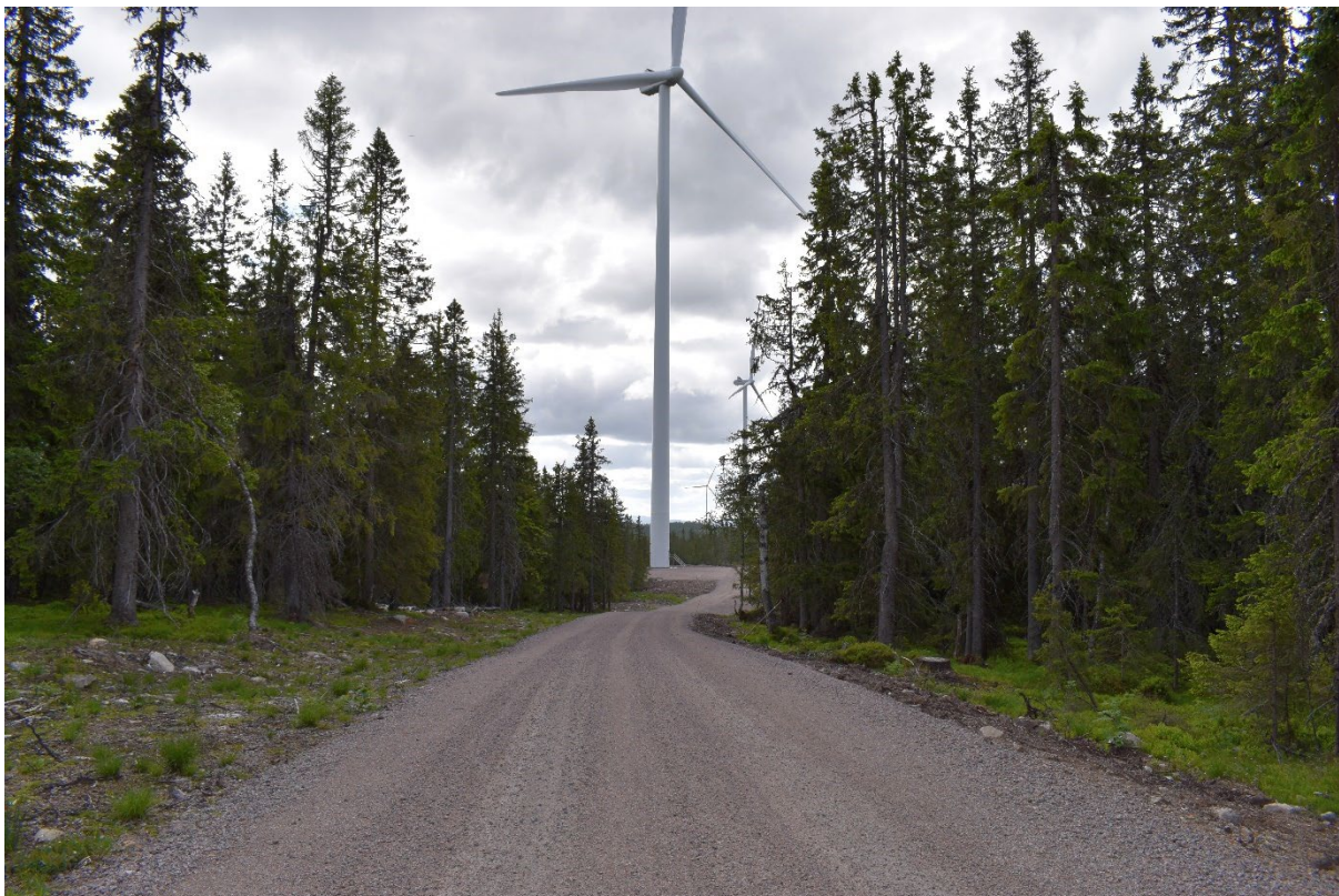
Figur 20. Vegparti mellom T3 og T6. Vegen er bygget gjennom naturtype «gammel barskog» og det er vektlagt å ha en redusert trasebredde, sammenlignet med anleggsveger i andre deler av planområdet.
