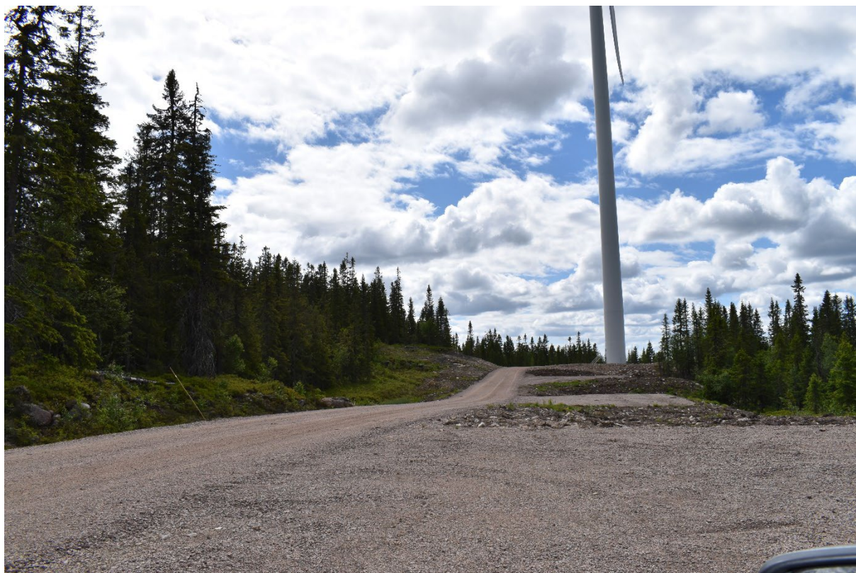
Figur 75. T13 Vegparti inn mot turbinpunkt med hjelpekranplasser.
