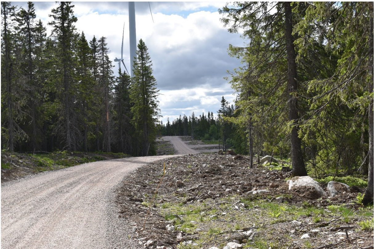
Figur 13. Vegparti mellom T2 og T3.
