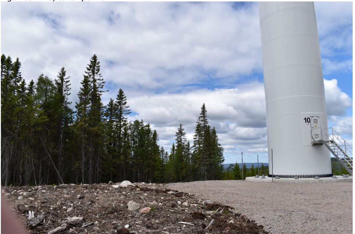
Figur 64. T10 turbinpunkt, sørside.
