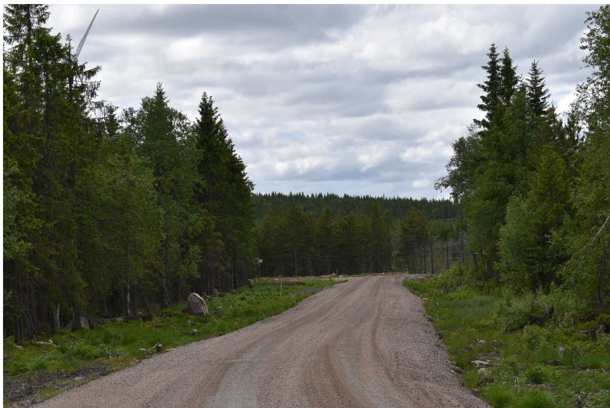
Figur 55. Vegparti mellom T9 og servicebygg.
