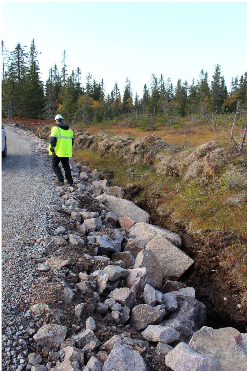
Figur 26. Myrkryssing mellom T4 og T5 før utlegging av vekstmasse på vegskulder. Grov blokk i vegfundamentet er synlig.
