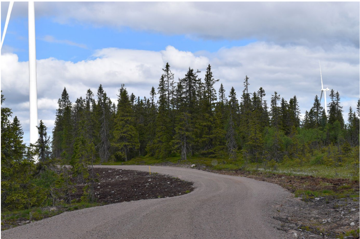
Figur 25. Vegparti mellom T4 og T5. Kryssing av myr.
