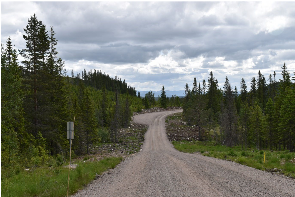
Figur 53. Vegparti mellom T9 og servicebygg.
