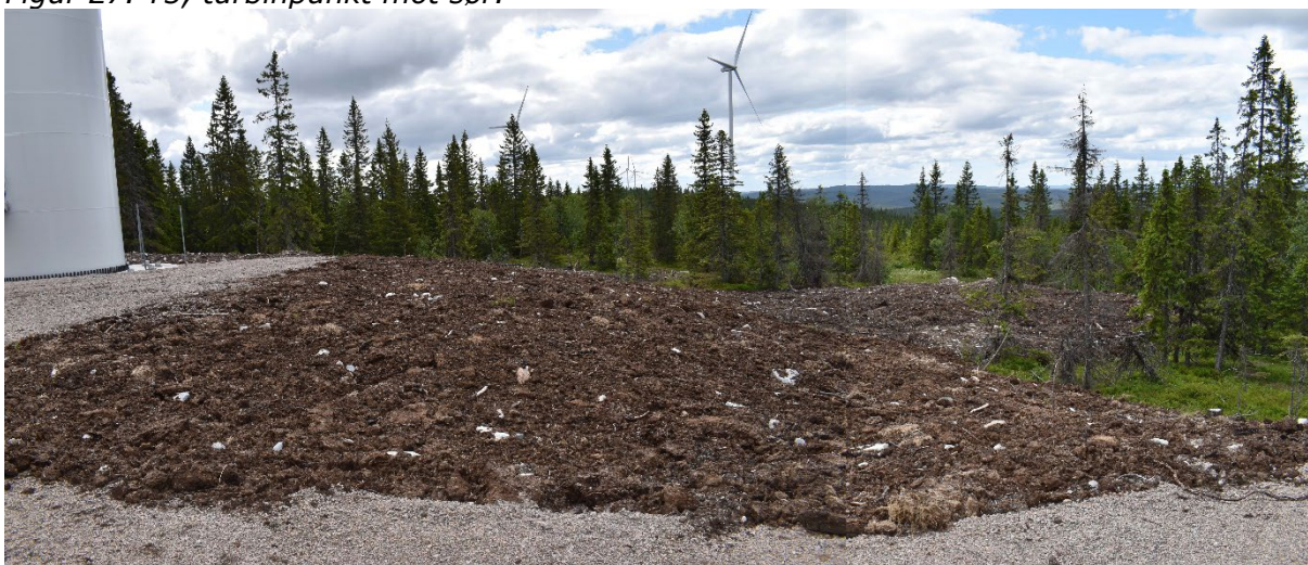
Figur 28. T5, turbinpunkt med deponi overskuddsmasser (panorama).
