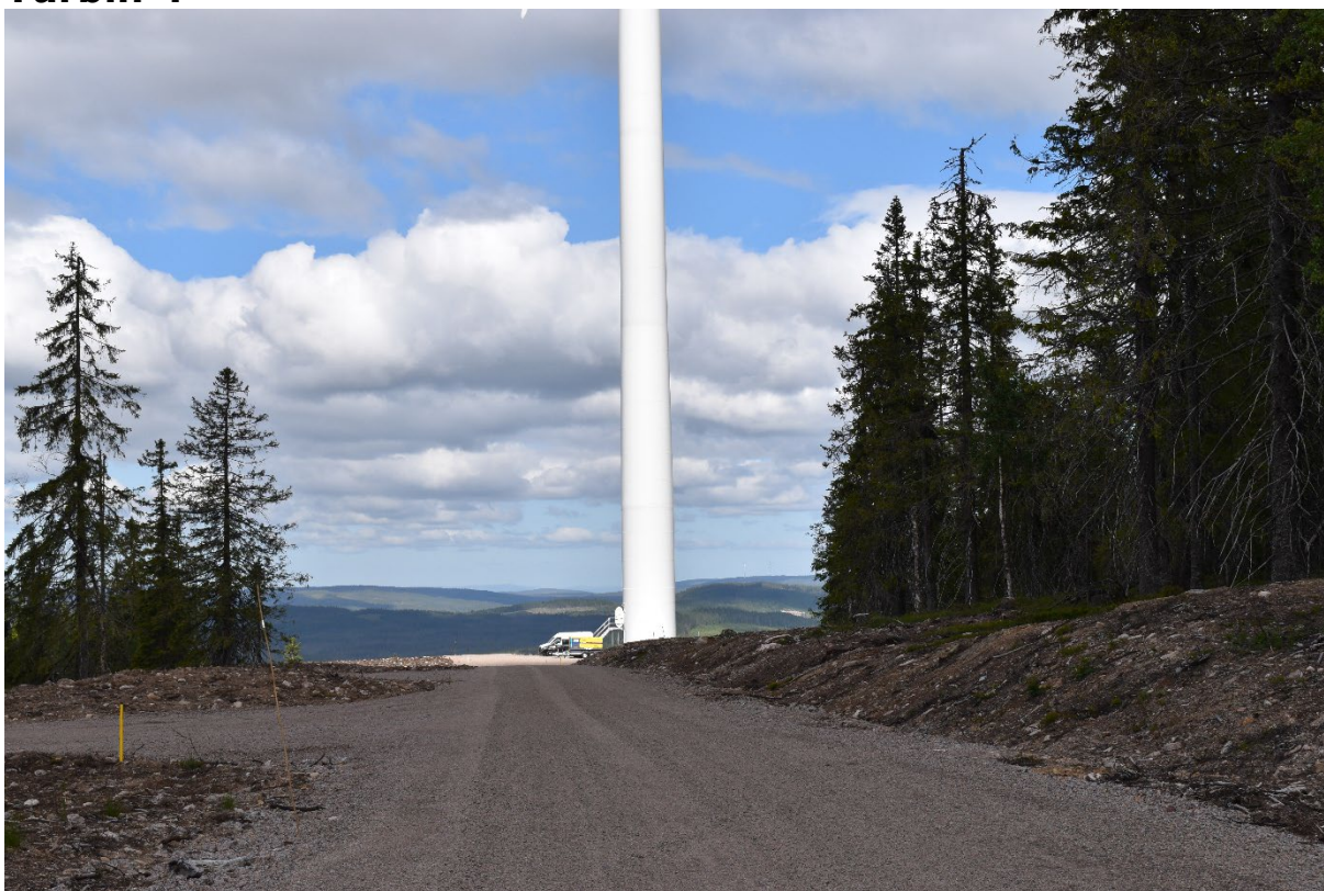
Figur 21. T4 hjelpekranplasser og vegparti inn mot turbinpunkt.
