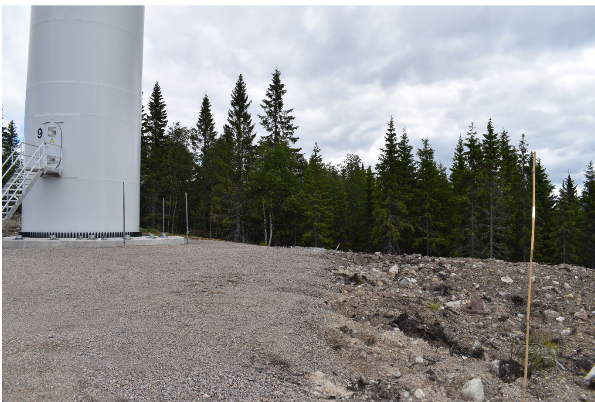
Figur 52. T9, turbinpunkt sørside.
