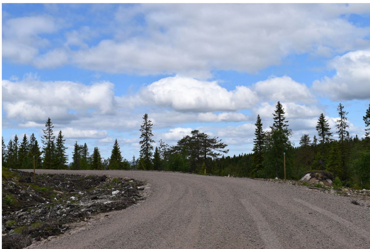
Figur 48. Vegparti mellom T9 og T7, med merking for kryssing av Finnskogleden.
