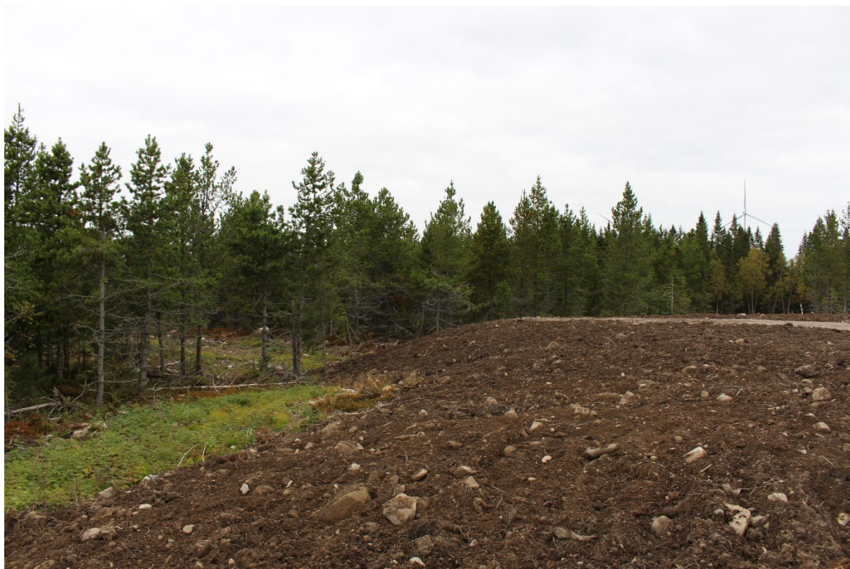
Figur 69. T11, turbinpunkt sørside.
