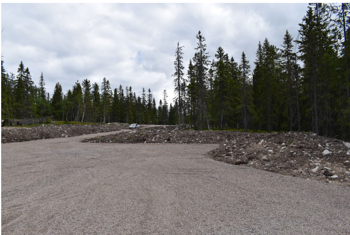
Figur 30. T5, turbinpunkt mot øst.
