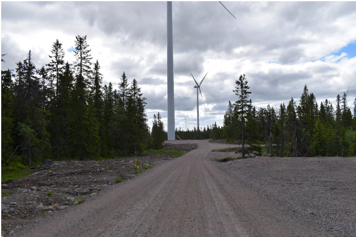
Figur 34. T6, vegparti inn mot turbinpunkt med hjelpekranplasser. Grantrærne på høyre side av vegen og mellom de to kranplassene er eksempel på igjensetting av trær langs veg for å bryte opp den visuelle effekten av ryddebeltet ved byggeområdene.
