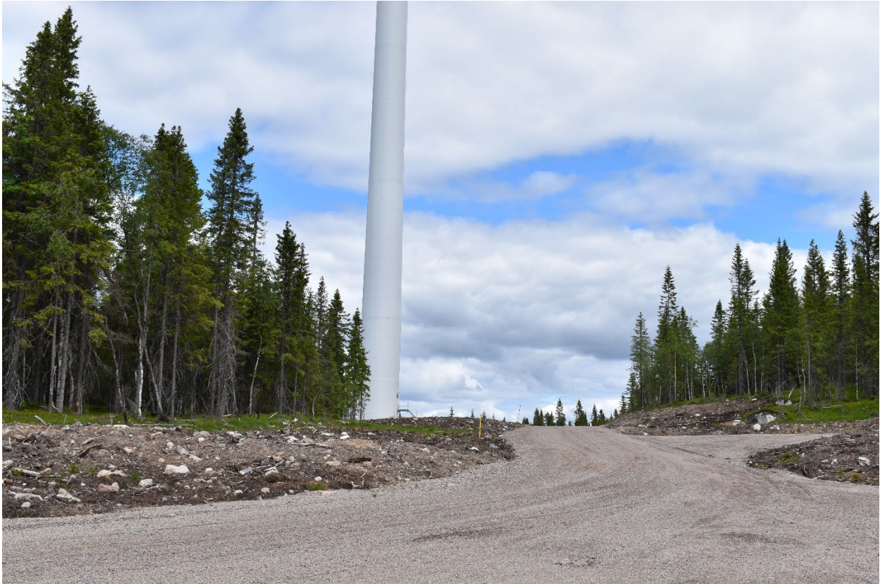
Figur 61. T10, Vegparti inn mot turbinpunkt og hjelpekranplasser til høyre.
