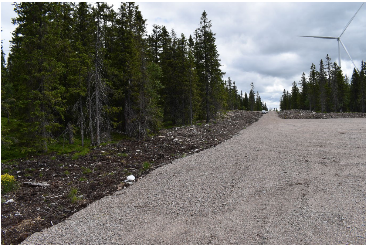
Figur 29. T5, turbinpunkt mot nord-øst.
