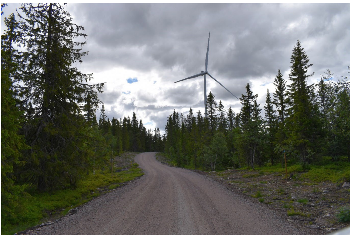
Figur 19. Vegparti mellom T3 og T6.
