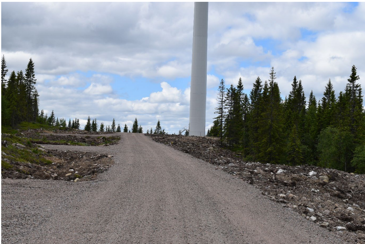
Figur 51. T9, hjelpekranplasser og vegparti fram mot turbinpunkt.
