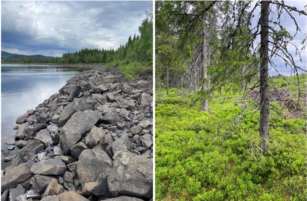
Figur 4-4: Til venstre: strandsonen i område for landkar til råvannspumpestasjonen og til høyre frisk blåbærskog i område for råvannspumpestasjon. Foto: COWI AS
