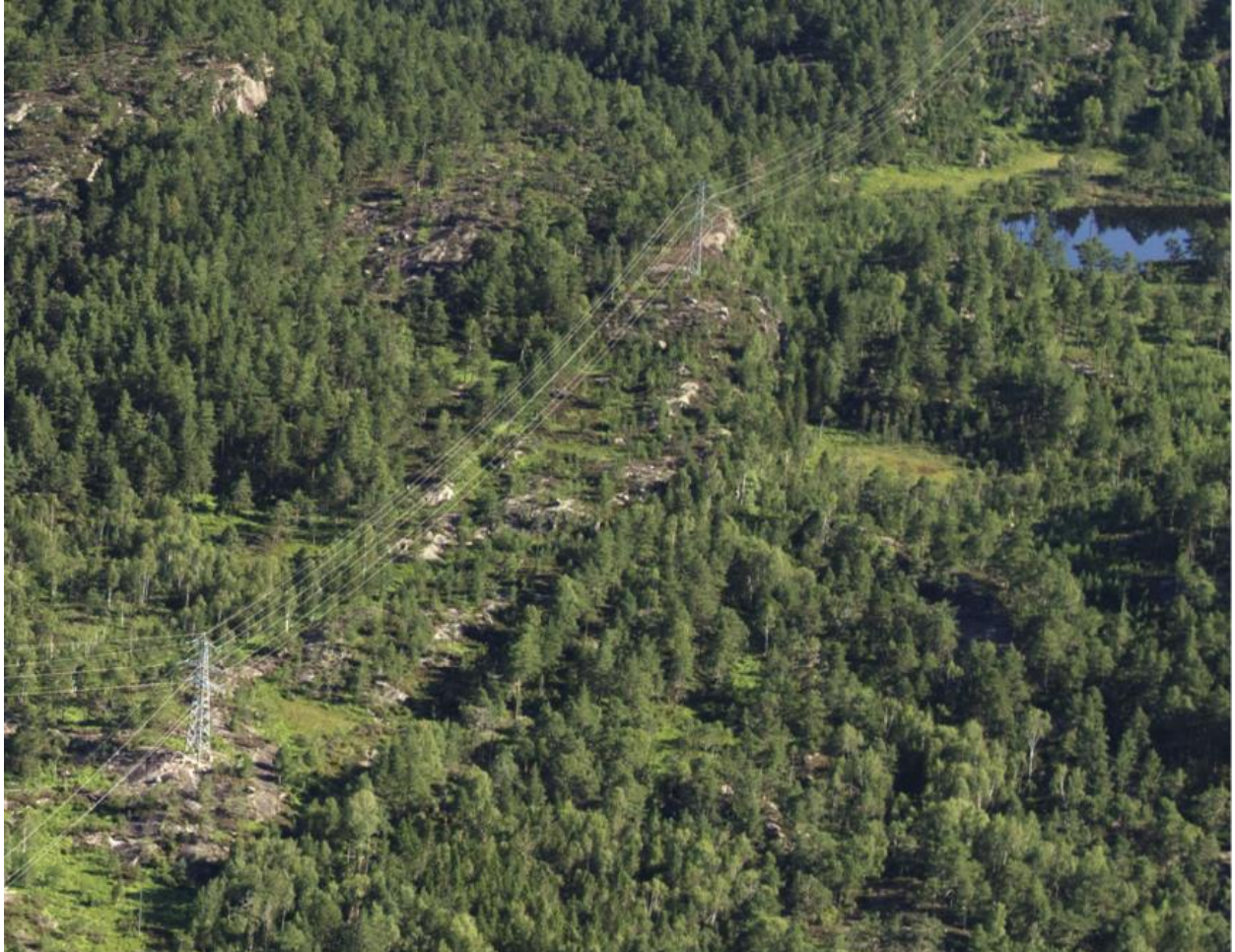
Sanering av 11 kV ledning Nomeland – Iveland, Iveland kommun
