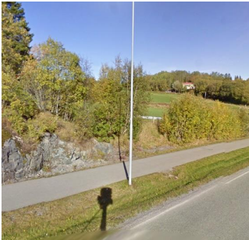
Figur 2 Utklipp google streetview ved fjelskjæring langs Fv 721, like vest for dalsøkket
