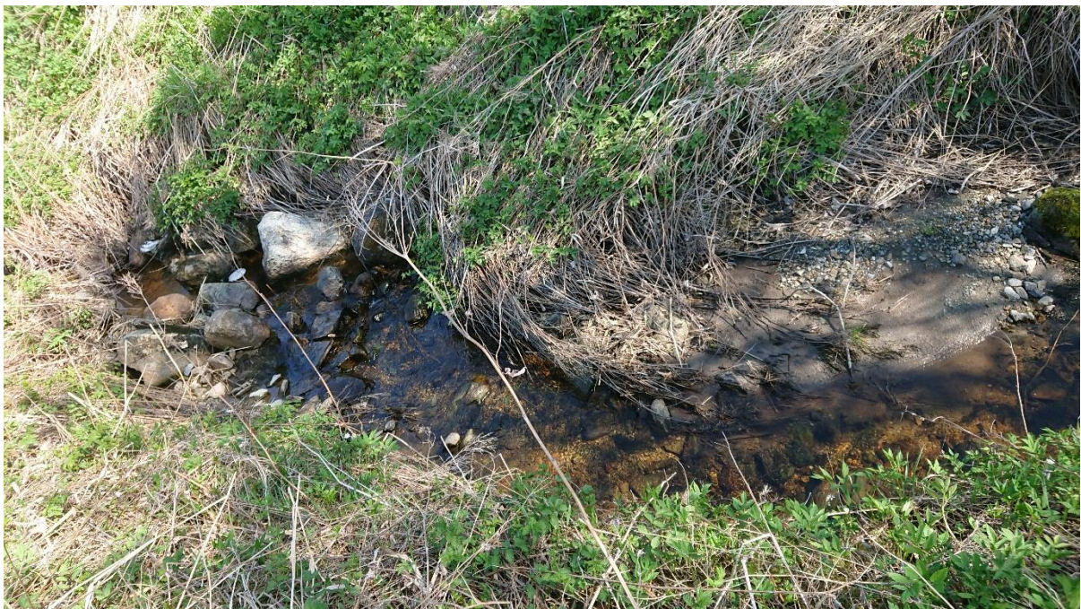
Figur 2 Bekk like oppstrøms kulvert
