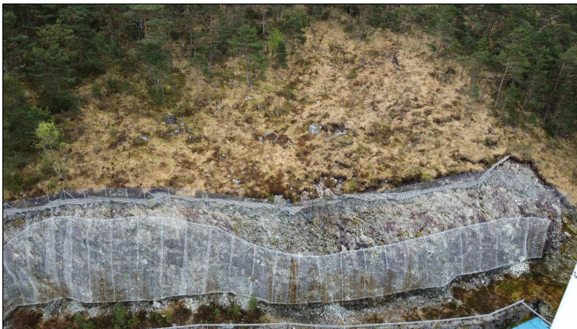
Figur 9. Naturlig flate og mulige steinsprangblokker over sprengt skjæring.
