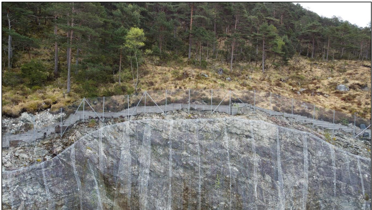
Figur 5. Sikringstiltak i sprengt skjæring i sørøst.
