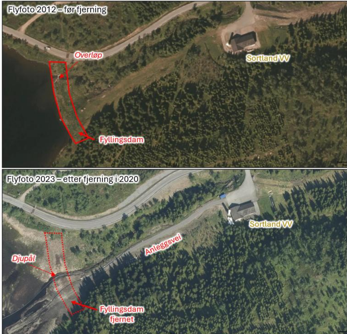
Figur 1-11 Flyfoto av utløpet til Storvatnet, hvor det tidligere var en fyllingsdam som ble fjernet i 2020.
