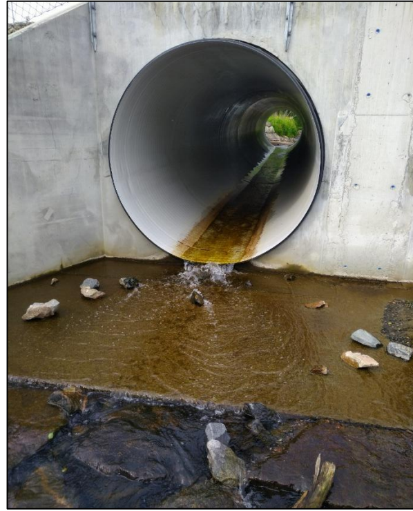
Figur 3-18 Utløpet av kulvert under Markveien har ca. 15 cm høyde på overheng og kan være vanskelig å passere for ålefaringer som i liten grad kan hoppe.
