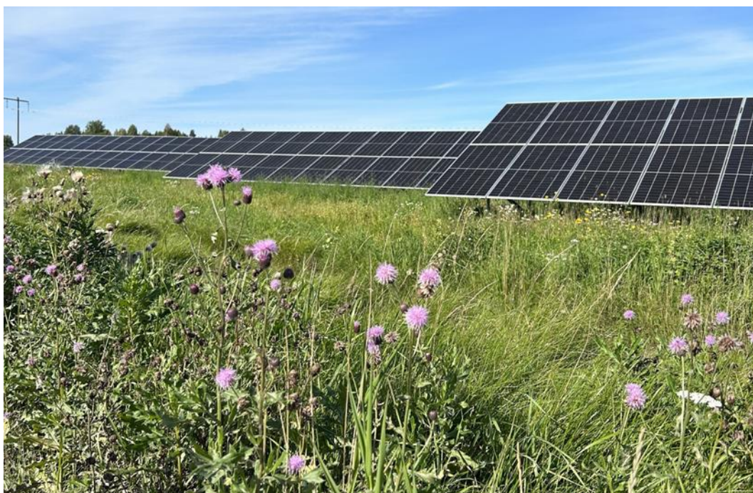
Figur 21 - Vegetasjon i solkraftverk sommeren etter bygging
