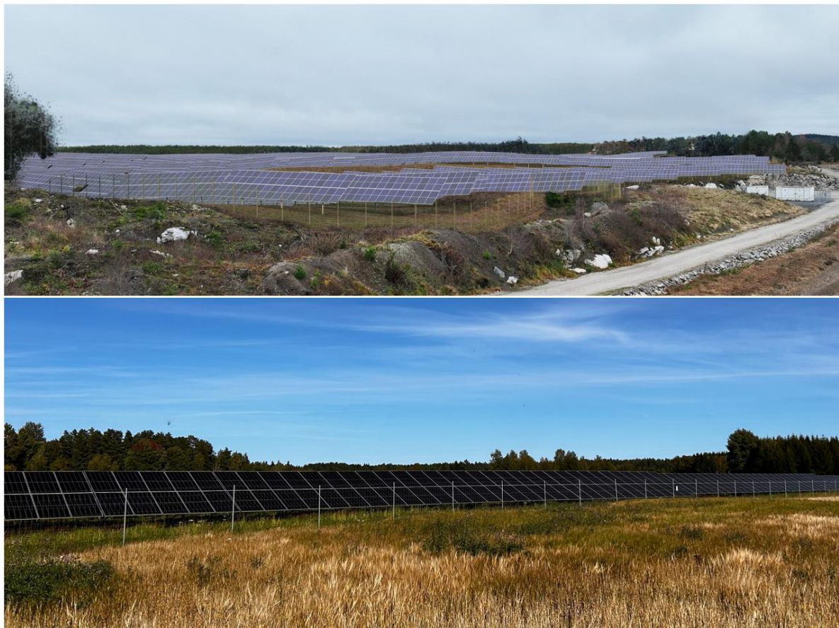
Figur 9 - Inngjerding av solkraftverk
