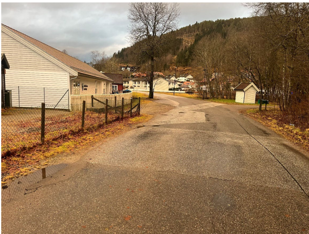
Kyrkjevegen sett fra øst mot vest. Den hvite bygningen til venstre er barnehagen i Kyrkjevegen 20. I bakgrunnen midt i bildet sees boligene med adresse Falkensteinsvegen.
