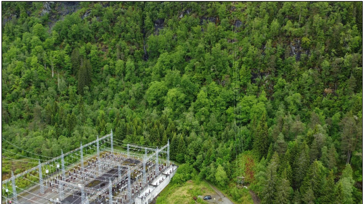
Figur 10. Oversikt over fjellsiden mot øst. Siden er skogkledd med noen eksponerte bergskrenter.
