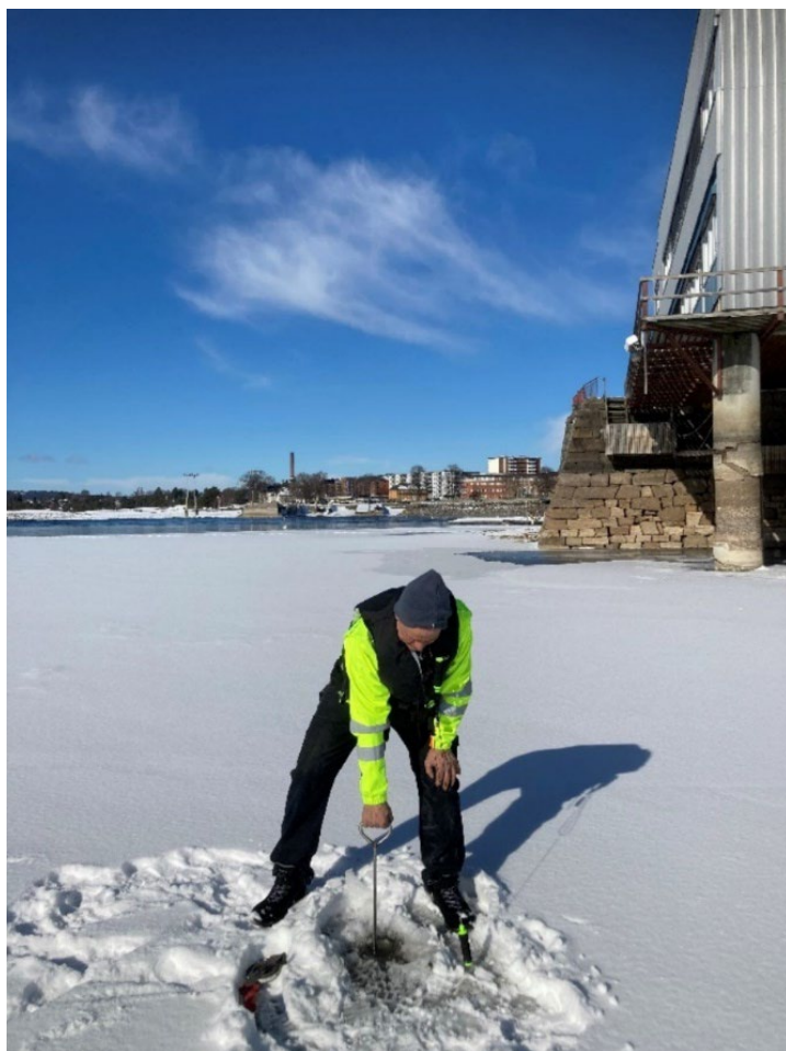
Figur 2-1 Bilde fra befaring 15.03.2023
