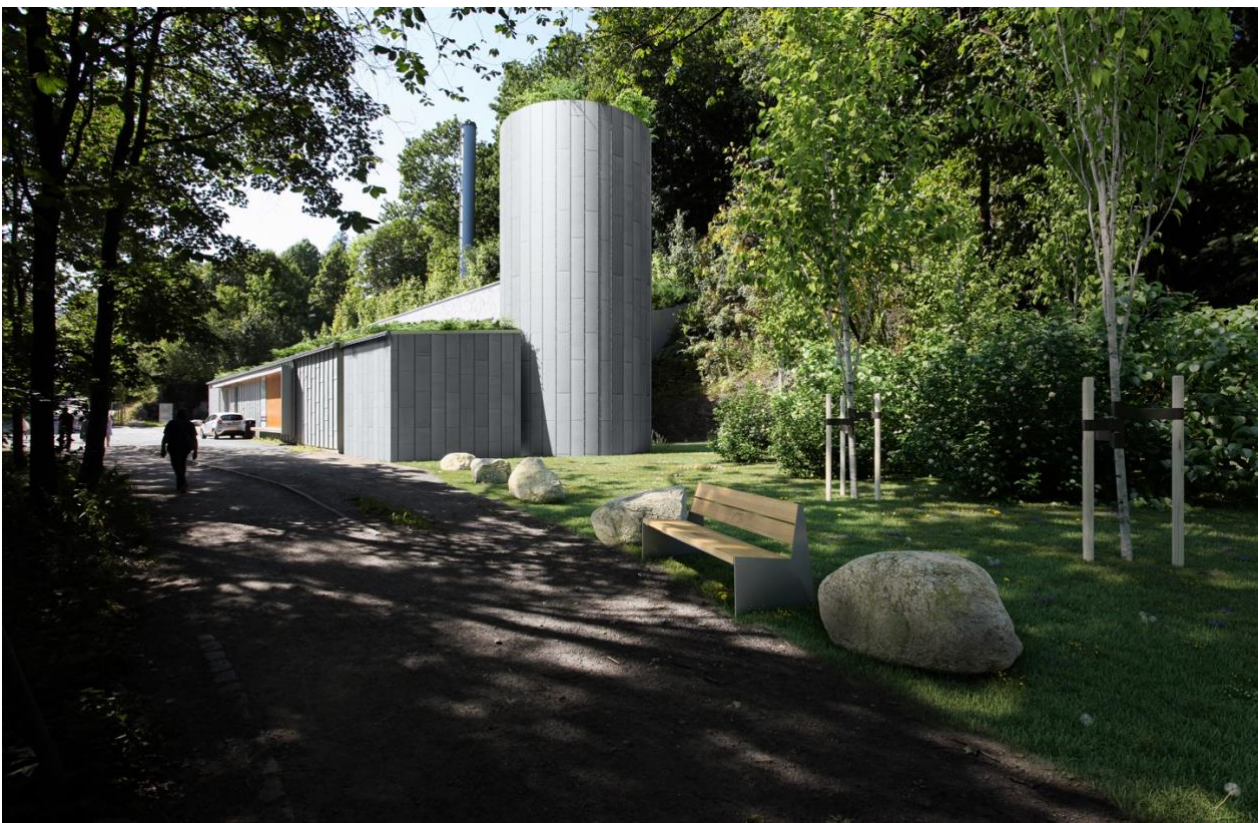
Fig. 7 Utvidet energisentral sett fra gateplan fra nord med beplantning nord for tilbyggene og parkmessig utforming av øvrig areal
