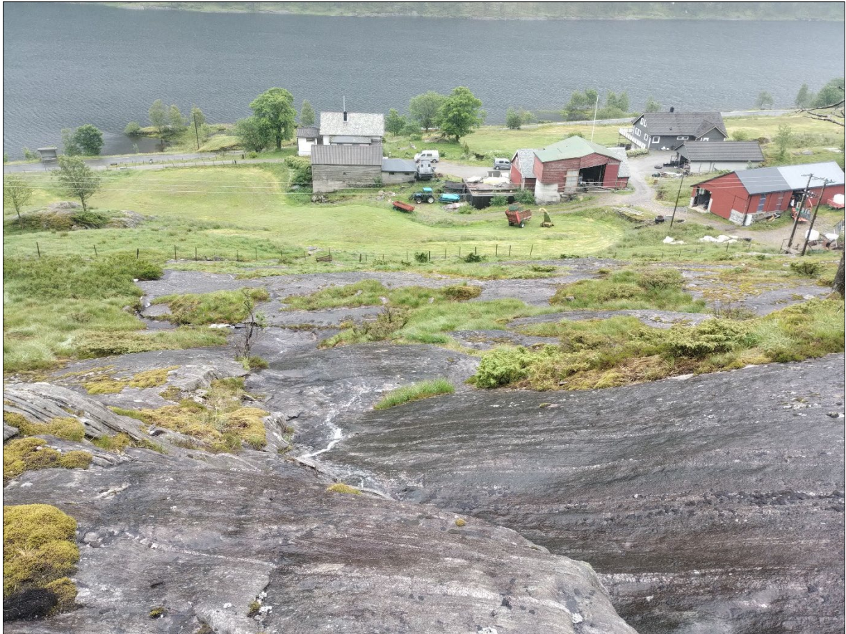
Figur 28: Drenering på fast fjell ned mot kartlagt område. Fra toppen av bøen og ned til busskuret renner vannet i rør under terrenget. Bildet er tatt ved infopunkt 4.
