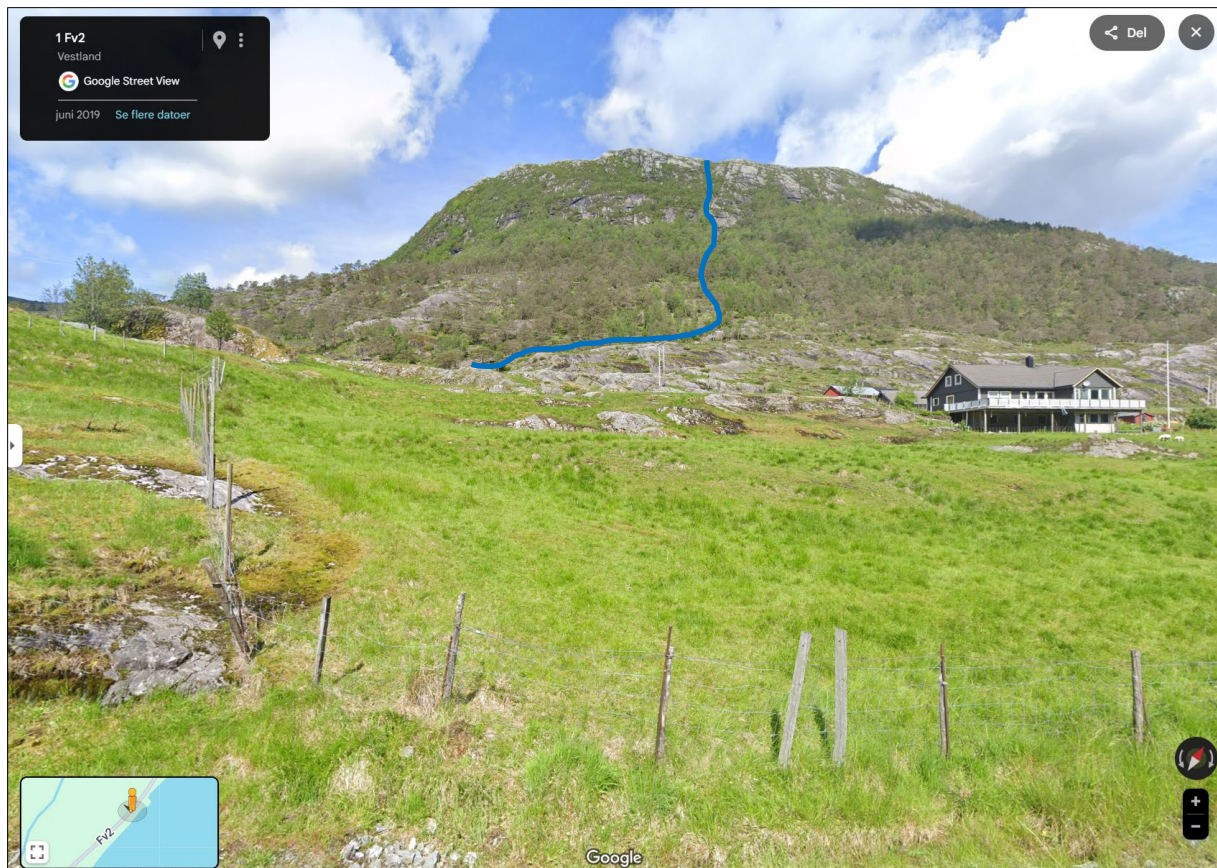
Figur 13: Bildet viser fjellsiden i påvirkningsområdet og bekkeløpet som drenerer fra toppen av fjellsiden. Blå linje i bildet indikerer ca. plassering av dreneringsveien som styres vest for kartlagt område. Foto: Google Street View. Infopunkt 3.
