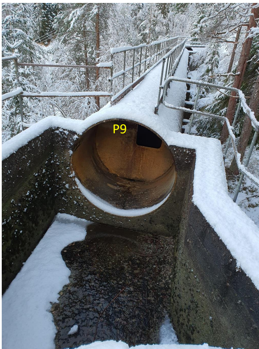
Figur 10. Uthoppet fra nest øverste rørseksjon. Alle rørseksjoner har både innhopp og uthopp i åpne betongkulper, noe som bidrar til både lystilgang og hvilekulper med større vannvolum og lavere grad av turbulens (foto: M. Kraabøl).
