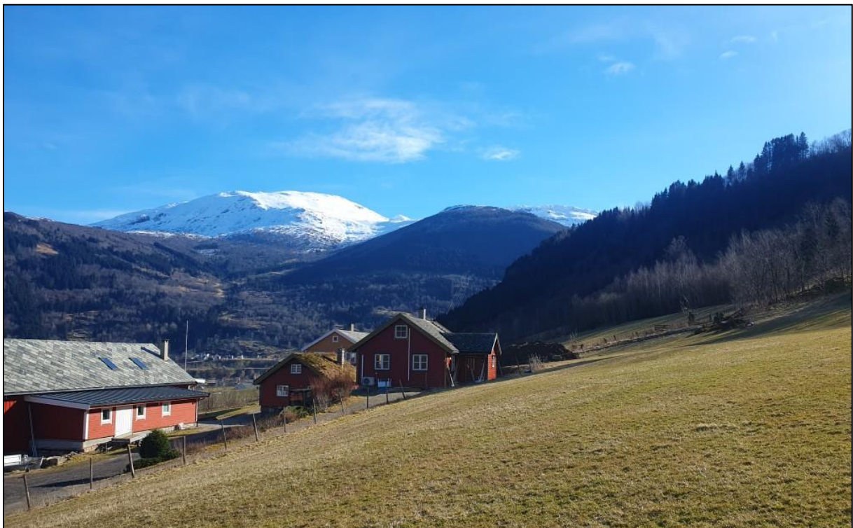
Figur 3: Bilde sendt av oppdragsgiver. Det røde huset og nærliggende terreng utgjør kartleggingsområdet.
