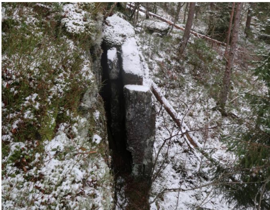
Bilde 3. Avløst bergblokk i den den østlige skråningen i elvedalen langs Sanddalselva.
