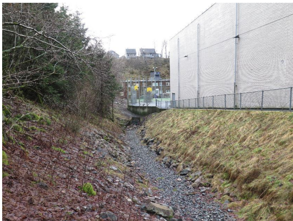
Bilde 2. Etablert skredvoll bak den sørlige delen av Sædalen skole.
