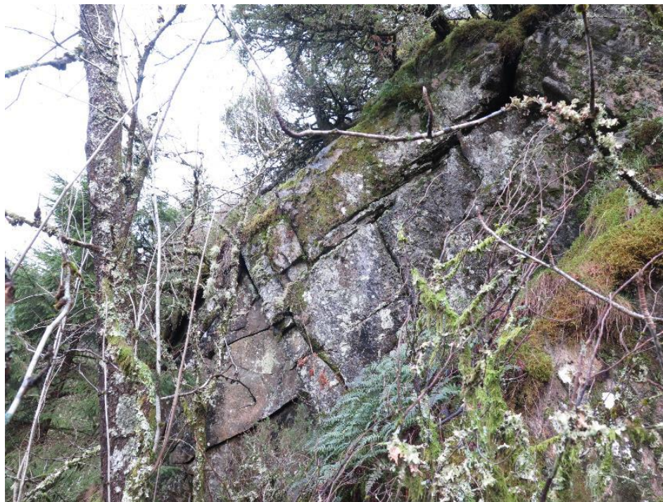
Bilde 1. Avløst bergparti i skråningen ovenfor den nordlige (nye) delen av Sædalen skole.
