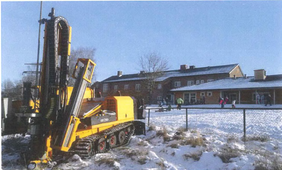
Bilde av borerigg ved Hovin skole
