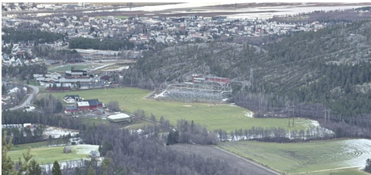
Figur 7: Innzoomet bilde av dagens transformatorstasjon, tatt fra Lille Raipas. Kilde: Aluts søknad
