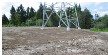
Figur 28: Mastepunkt som er tilbakeført som en stor glatt flate. Her burde flaten vært brutt opp ved å lagde forhøyninger og forsenkninger. I tillegg burde det vært plassert ut vegetasjonstuer for at naturlig vegetasjon raskere kan reetableres.
