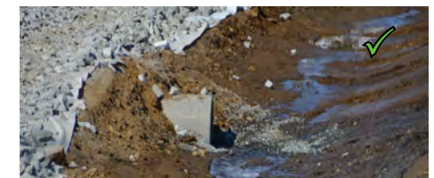
Figur 7: Ved etablering av tilkomster skal entreprenør sikre at eksisterende vannveier/vannsig ikke endrer løp. Dette kan enten gjøres ved å legge rør under, eller lede vann over en erosjonssikret del av kjøreflaten.
