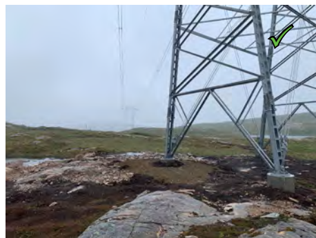
Figur 22: Her er sprengsteinsblokk fjernet fra overflaten.
