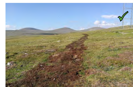
Figur 33: Godt istandsatt kjørespor.
