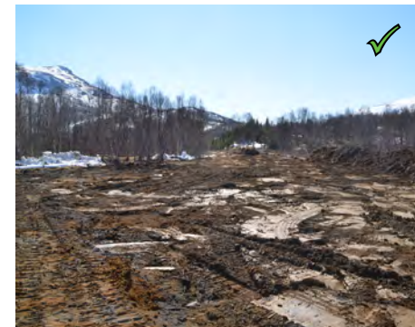
Figur 14: Topplaget er skåret av og lagret i ranke til høyre i bilde. Massene skal benyttes ved istandsetting.
