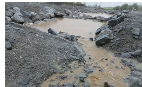
Figur 37: Eksempel på konstruert sedimentsasjonsbasseng for avrenning fra stasjonstomt. Utløpet er neddykket slik at eventuelle oljerester legger seg på overflaten.
