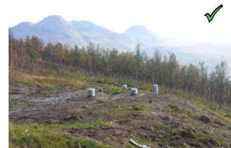
Figur 25: Toppmasser er lagt tilbake slik at naturlig revegetering kan starte. Massene er i tillegg lagt ut slik at overgang mellom omliggende terreng og punktet, blir naturo.
