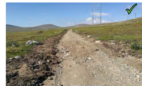
Figur 32: Godt tilrettelagt kjørespor der vegetasjonsmasser er lagt til side for istandsettingen
