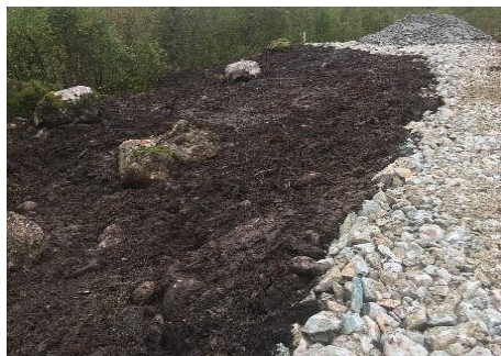
Figur 35: Istandsatt sideterreng i tråd med veilederen fra landbruksdirektoratet, "Skogsbilvegbygging med miljøhensyn".
