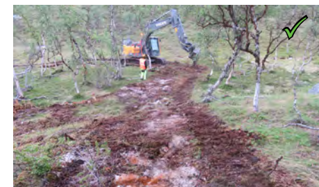
Figur 31: Ved uttransportering av maskiner og utstyr, skal kjørespor legges i grunn og pusses. Gjennlagte spor skal ikke på nytt benyttes uten avklaring med Statnett
