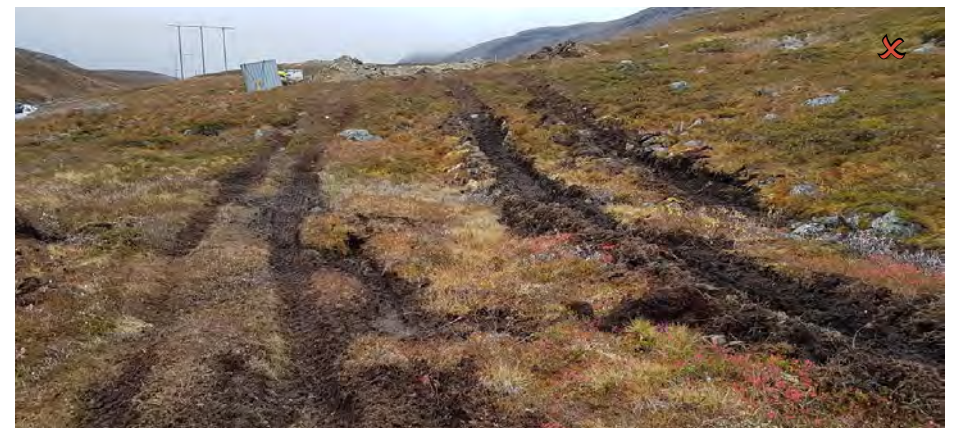
Figur 8: Når det etableres et nytt kjørespor, skal dette benyttes. Entreprenør skal terrengforsterke fremfor å etablere parallellt spor.
