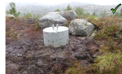
Figur 20: God overgang mellom stabbe og terreng.
