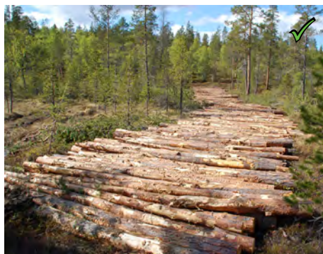
Figur 11: Eksempel på forsterket terreng i form av klossing med tømmerstokker.
