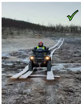
Figur 10: Eksempel på etablert terrengforsterkning over bløte partier.
