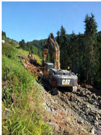
Figur 34: Opprusting av landbruksveg med stedege masser.
